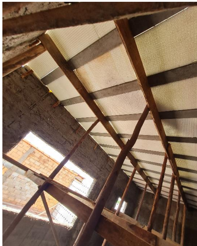
Figura 4.13 Lajes treliçadas montadas sobre as paredes de EPS
