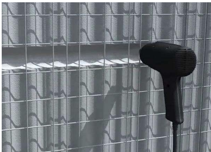
Figura 4.9 Abertura de sulcos para instalações complementares
