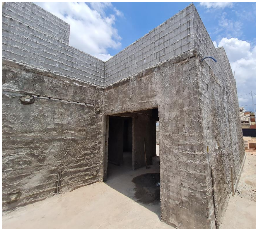
Figura 4.12 Parede de EPS coberta de argamassa
