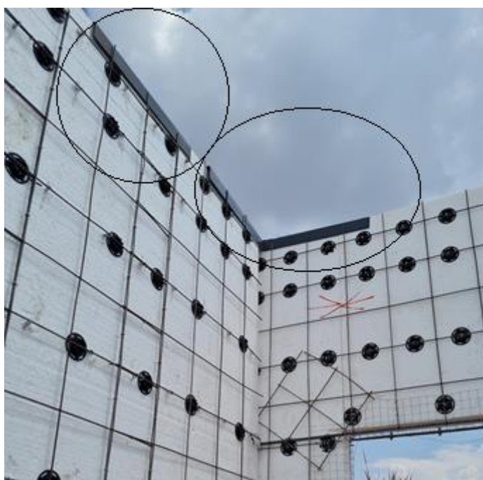
Figura 4.7 Gabaritos utilizado na união das paredes (obtenção esquadro)
