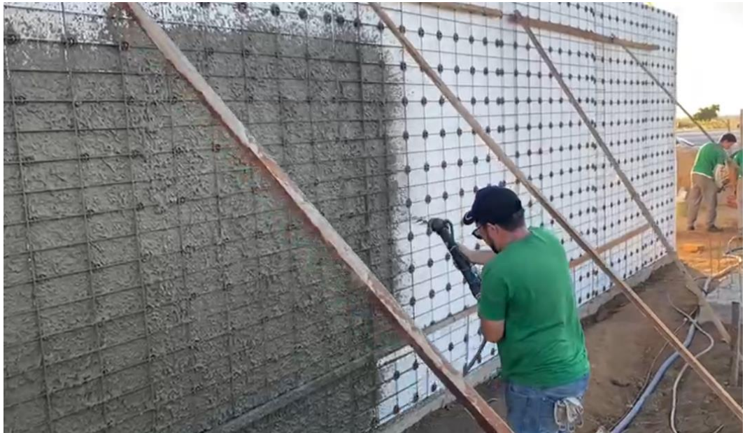
Figura 4.11 Projeção de argamassa nas paredes
