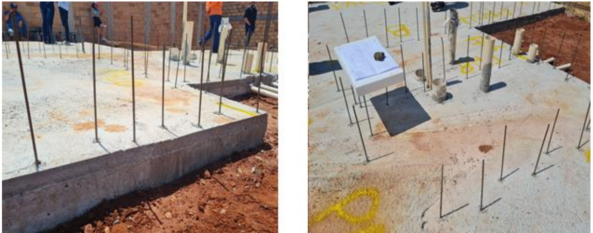
Figura 4.1 Disposição das barras de ancoragem
