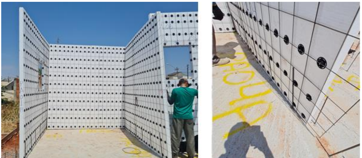
Figura 4.2 Ancoragem dos painéis
