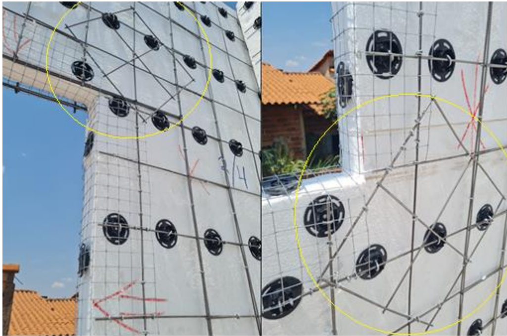
Figura 4.4 Reforços em laterais e cantos das aberturas
