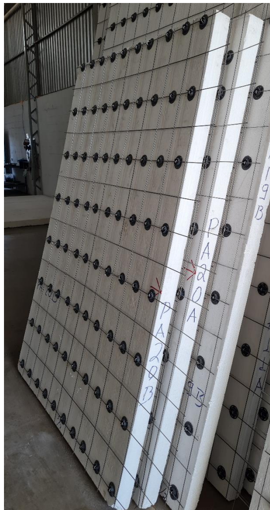
Figura 3.1 Núcleo de EPS com Armaduras
