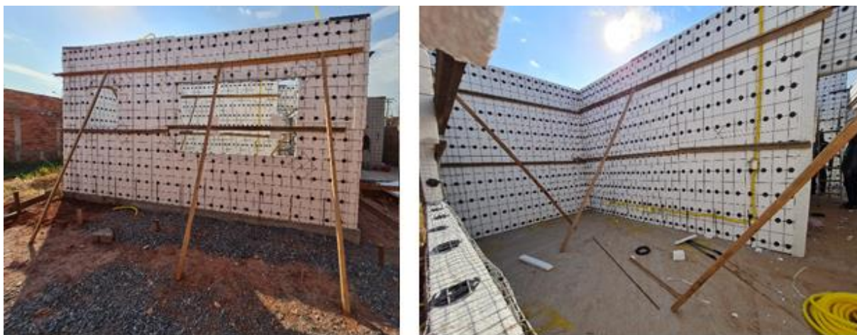
Figura 4.10 Travamento das paredes com sarrafos e escoras de madeira
