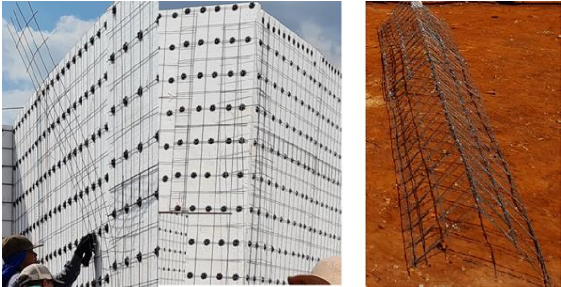
Figura 4.3 Amarração das telas entre si
