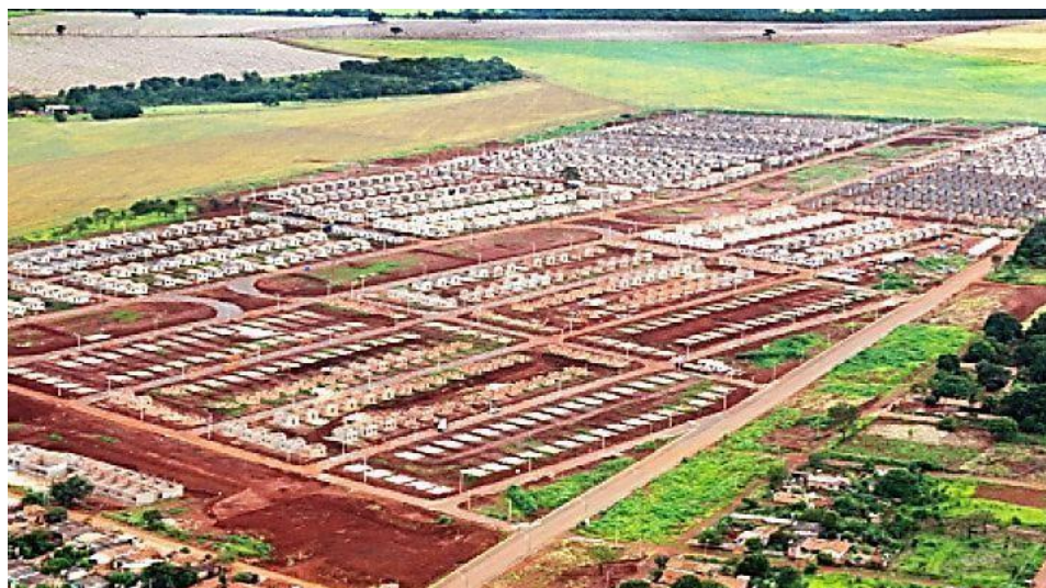
Figura 2: Bairro Cidade Jardim Etapa I - Jataí-GO durante a fase de construção.
