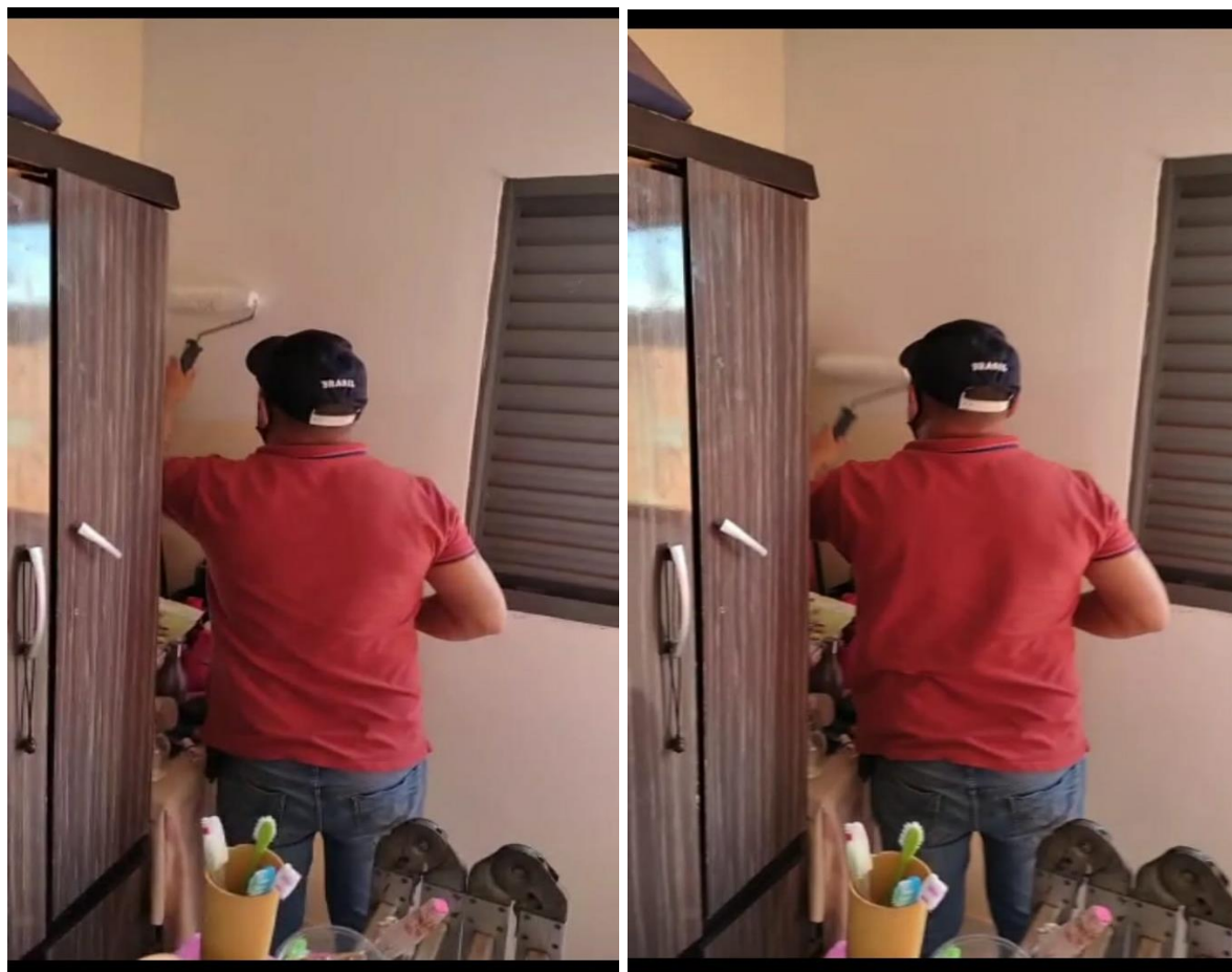
ANEXO1- Pintura da parede interna
