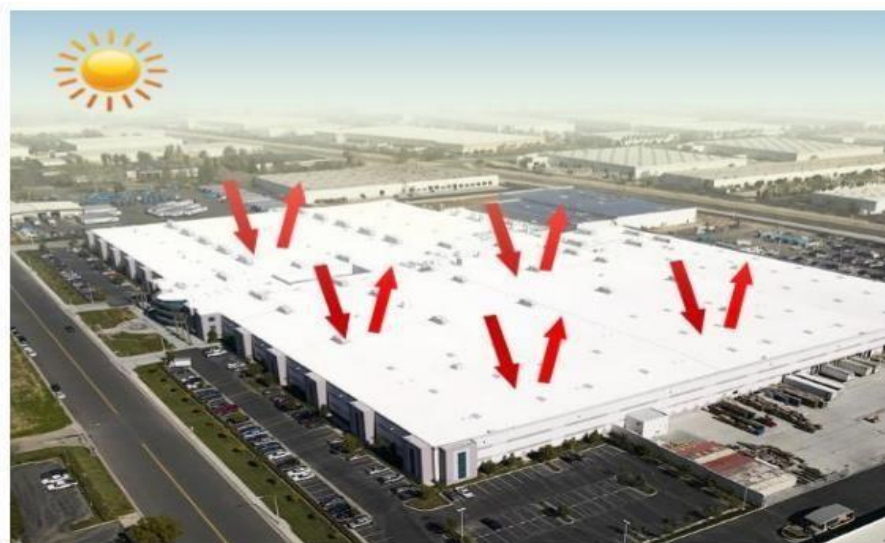
Figura 07 – Tinta Isolante térmica aplicada sobre cobertura
