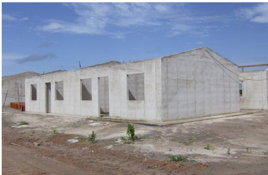
Figura 4: Edificação construída com parede de concreto.
