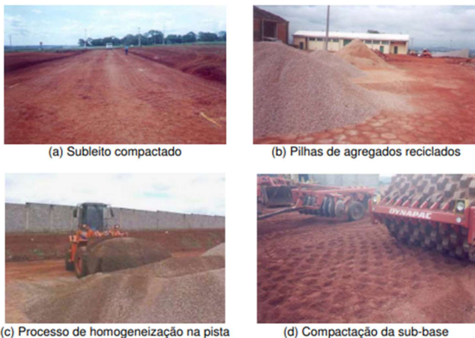
Figura 3.6 - Detalhes construtivos da execução da pista
