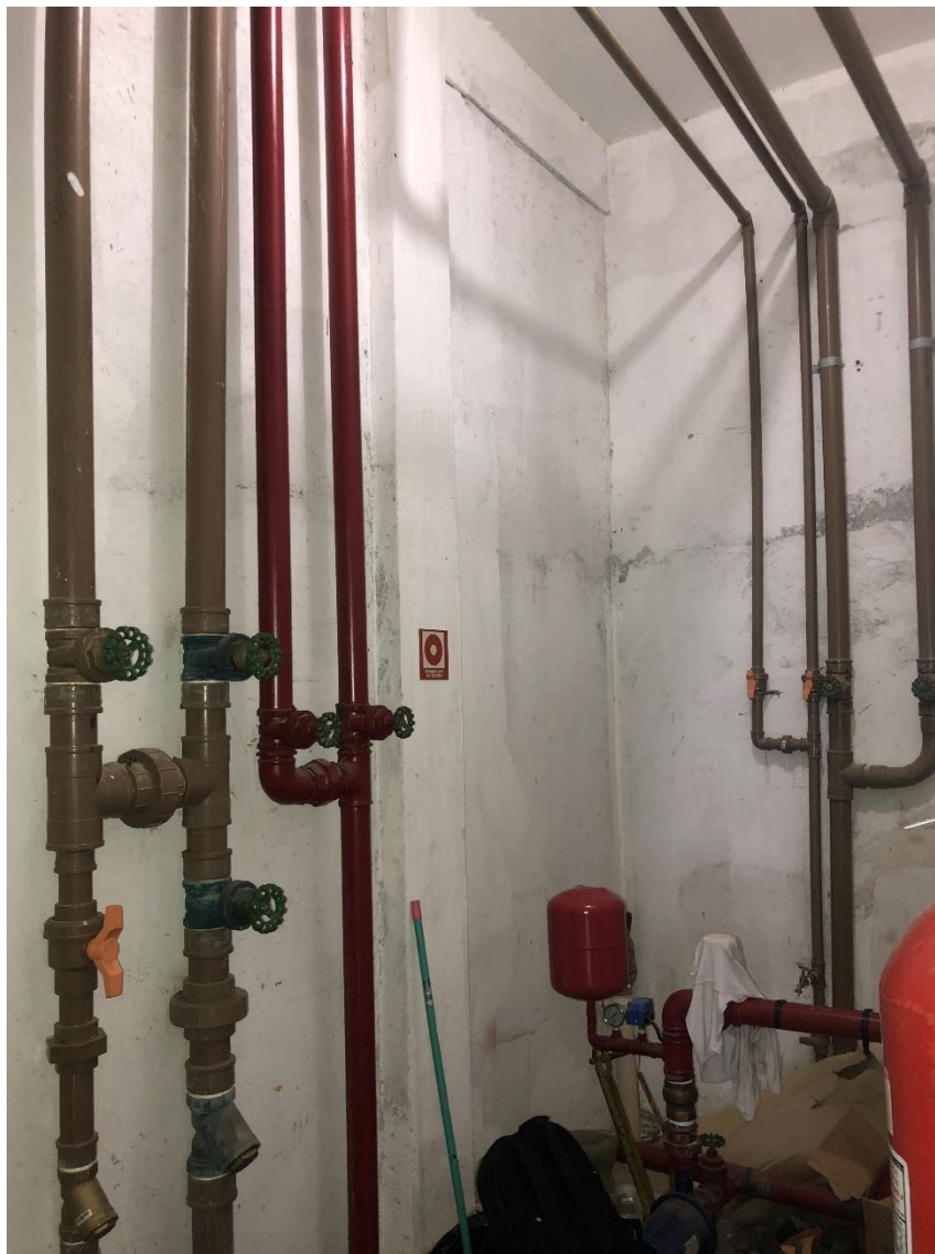
Figura 34 – Ambiente do Barrilete no “Empreendimento A”.
