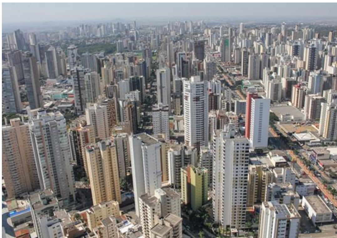
Figura 1 – Vista aérea de Goiânia apresentando a verticalização na cidade.
