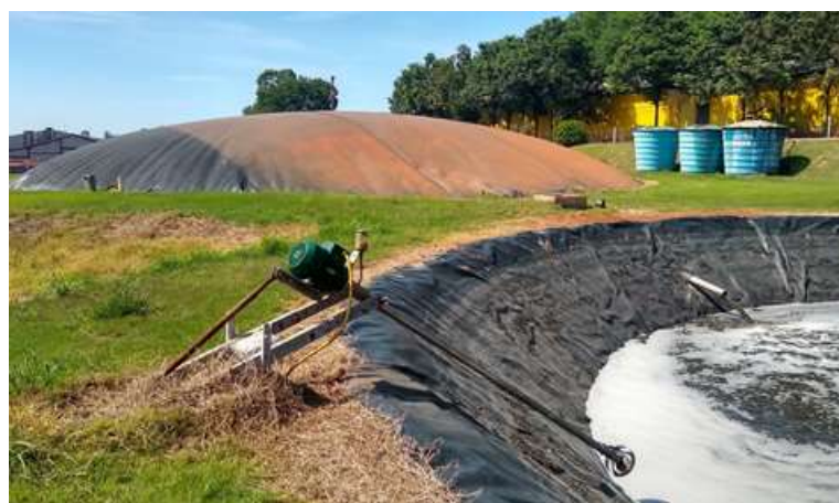
Figura 10 - Reator BLC em formato circular e agitador mecânico em Entre Rios do Oeste – PR – Brasil.
