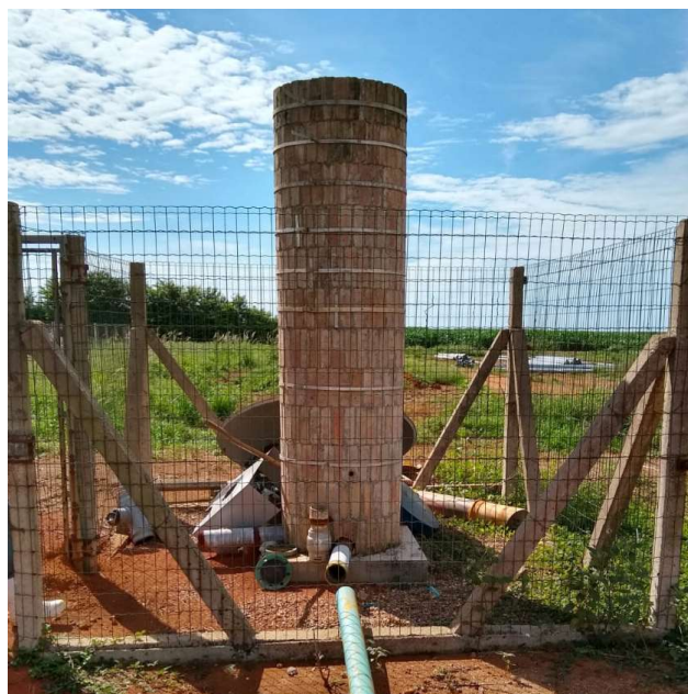
Figura 21 - Queimador de biogás em uma Granja de Suínos em Campo Verde – MT.
