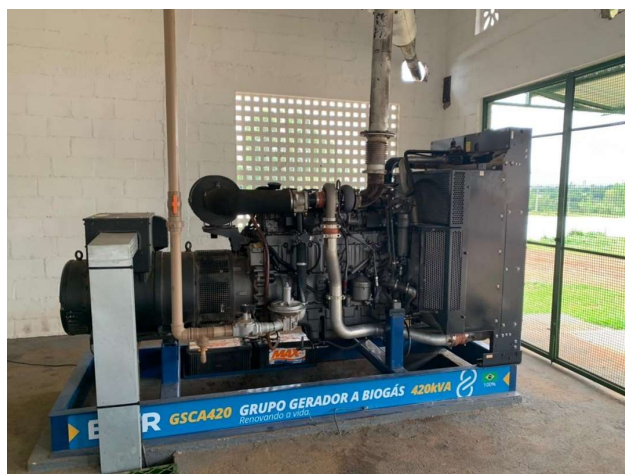
Figura 23 - Motogerador utilizado na geração distribuída de energia em uma agroindústria em Bela Vista – Goiás.
