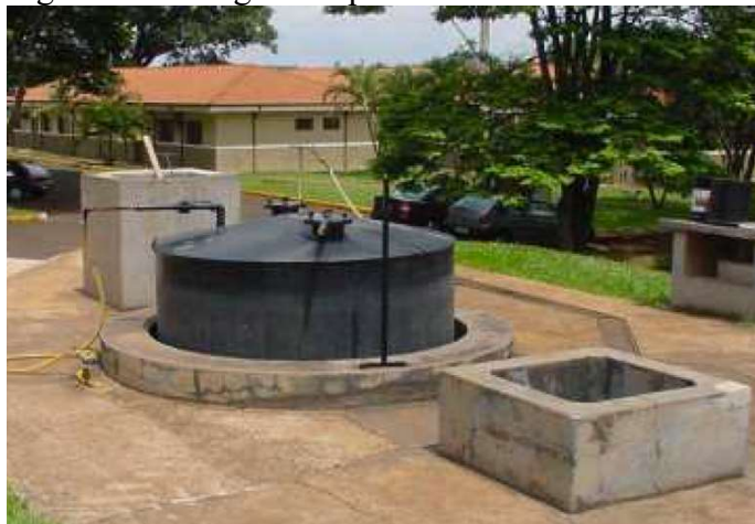
Figura 8 - Biodigestor tipo “Indiano”.
