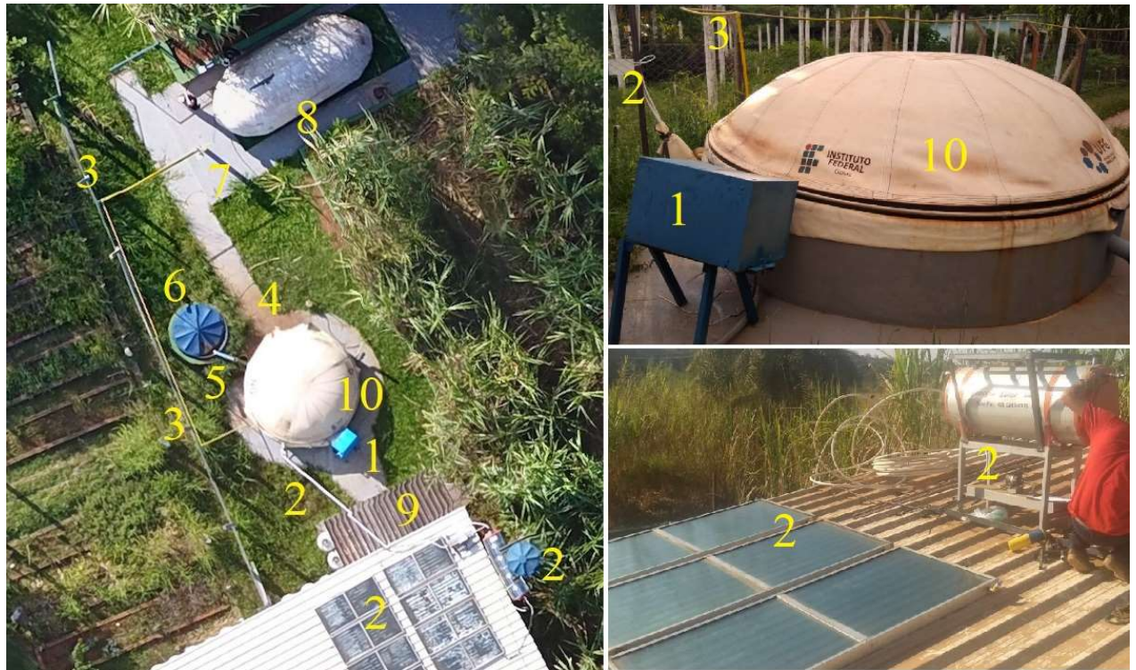
Figura 38 - Biodigestor CSTR no BiogasLab IFG-UFG.
