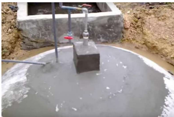
Figura 7 - Biodigestor tipo “Chinês” com cúpula fixa.
