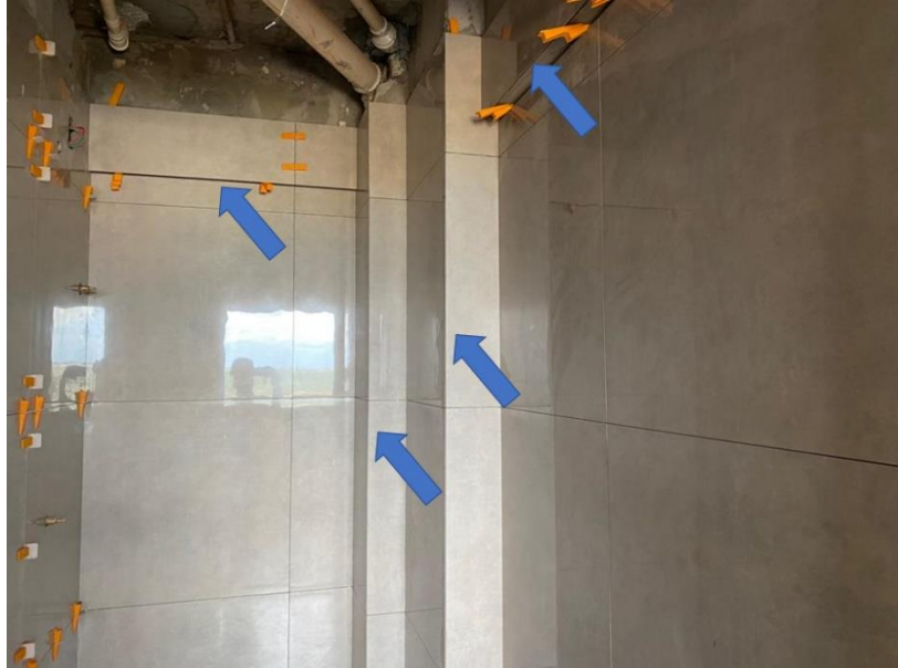
Figura 4.22 - Cortes meia esquadria realizados no lavabo de serviço
