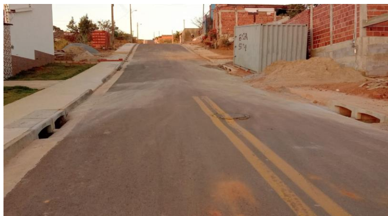
Figura 30 – Bocas de lobo duplas na rua Aeroviários
