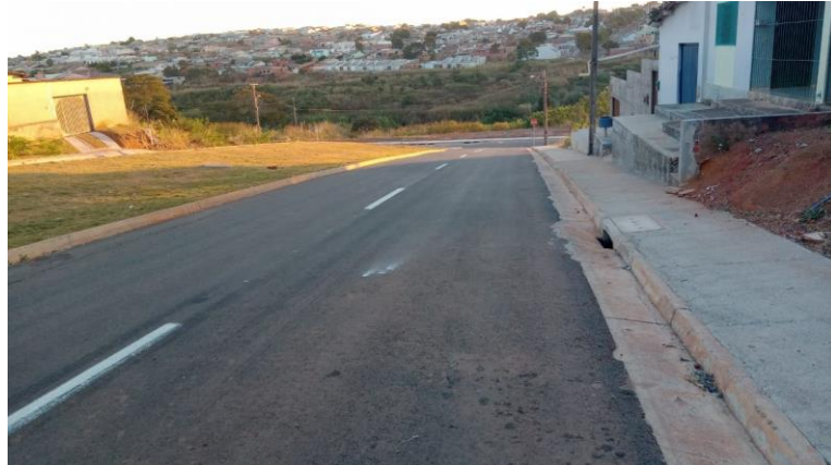
Figura 27 – Boca de lobo simples na Av. Nacional
