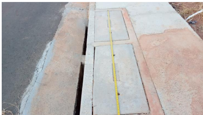
Figura 14 - Levantamento das dimensões das bocas coletoras
