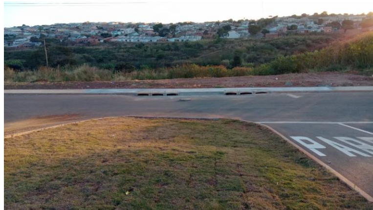
Figura 28 – Bocas de lobo triplas no encontro da Av. Nacional com rua dos Industriários
