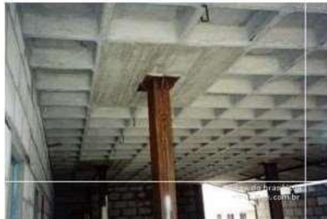
Figura 4 - Laje nervurada moldada sem material de enchimento.
