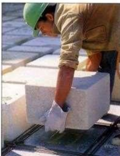
Figura 3 - Laje nervurada moldada no local com enchimento em bloco de concreto celular auto clavado.
