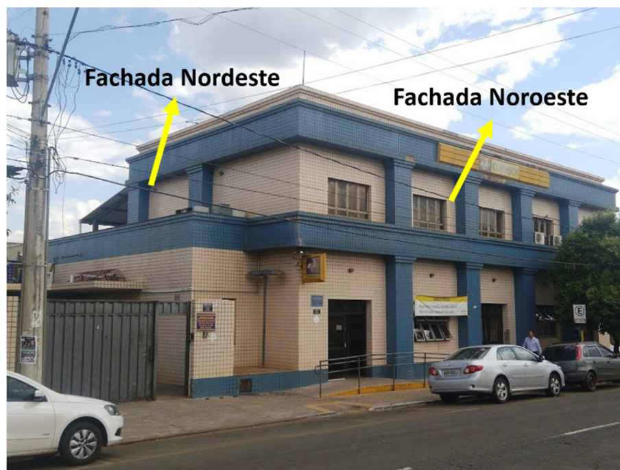
Figura 21 – Fachada Nordeste e Noroeste
