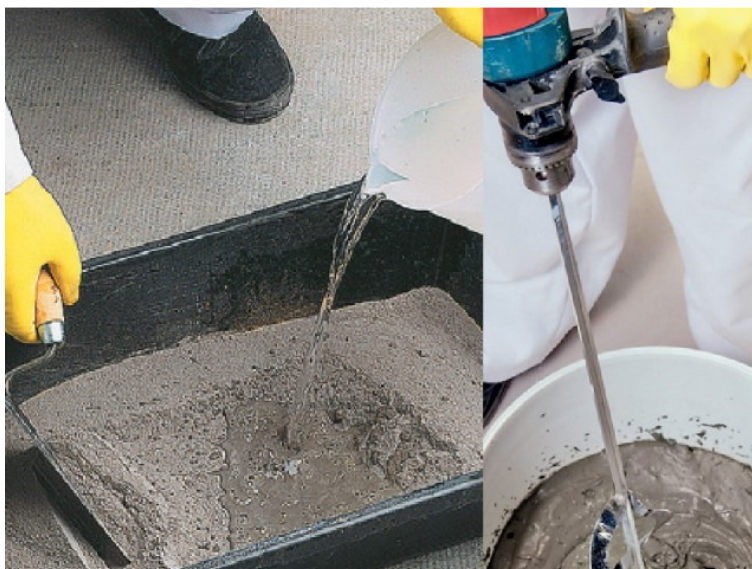
Figura 14 – Adição de água à argamassa industrializada
