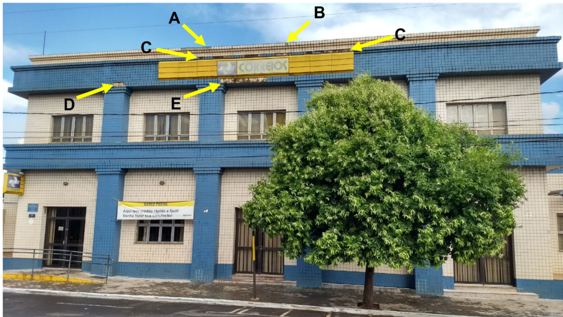
Figura 28 – Fachada Noroeste (a) descolamentos regiões A, B, C Lado Direito , C Lado Esquerdo , D e E; (b) descolamento região F; (c) foco região crítica.
