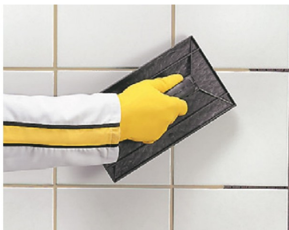
Figura 7 – Rejuntamento de placas cerâmicas
