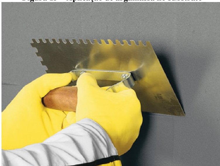
Figura 15 – Aplicação de argamassa no substrato
