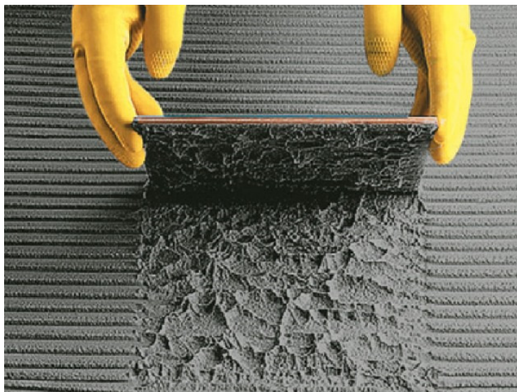
Figura 18 – Verificação da execução do revestimento cerâmico
