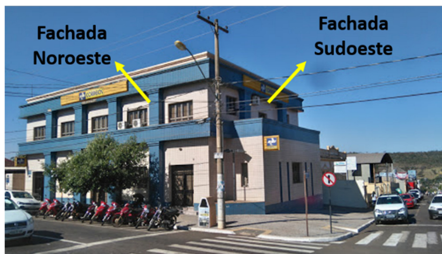
Figura 20 – Fachada Noroeste e Sudoeste
