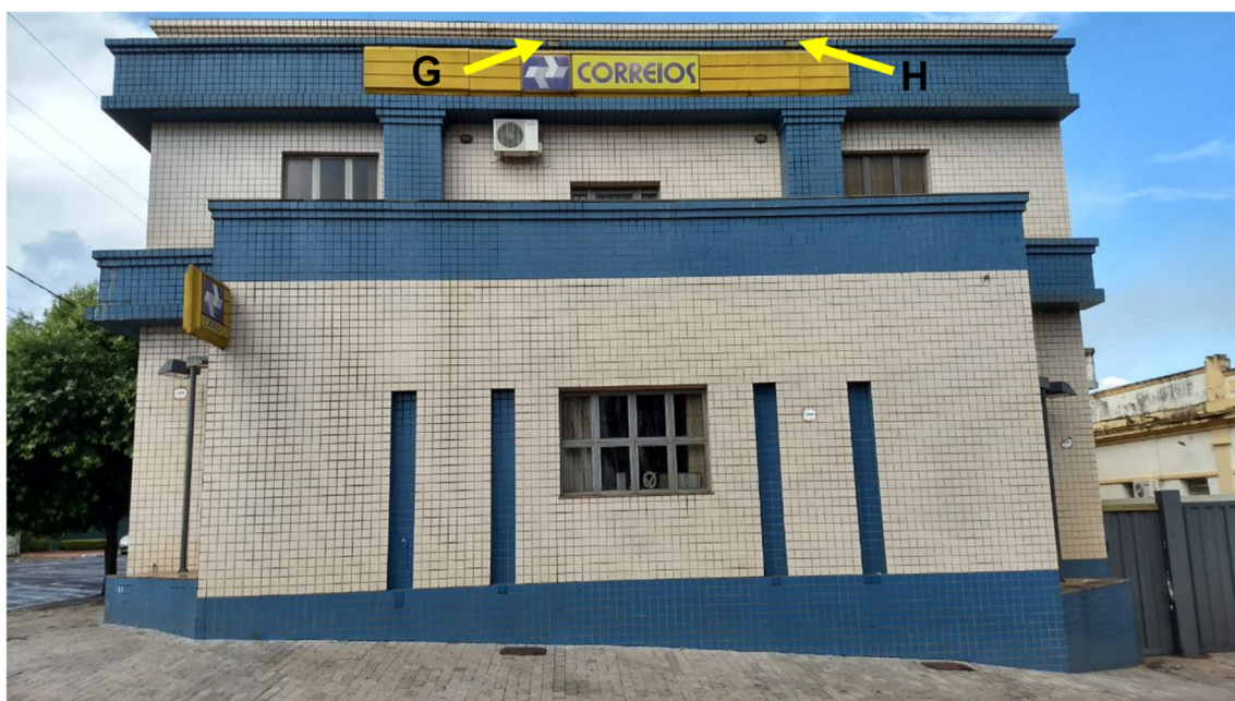
Figura 29 – Fachada Sudoeste: regiões de descolamento G e H
