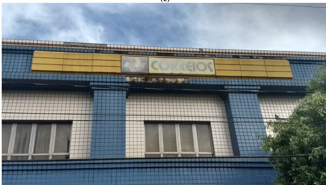
Figura 29 – Fachada Sudoeste: regiões de descolamento G e H
