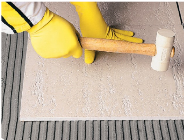
Figura 17 – Assentamento da placa cerâmica sobre os cordões de argamassa colante
