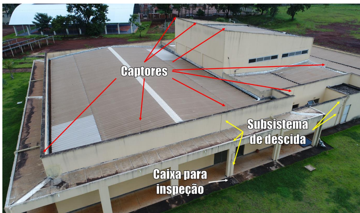
Figura 49: SPDA e vista aproximada do Refeitório.
