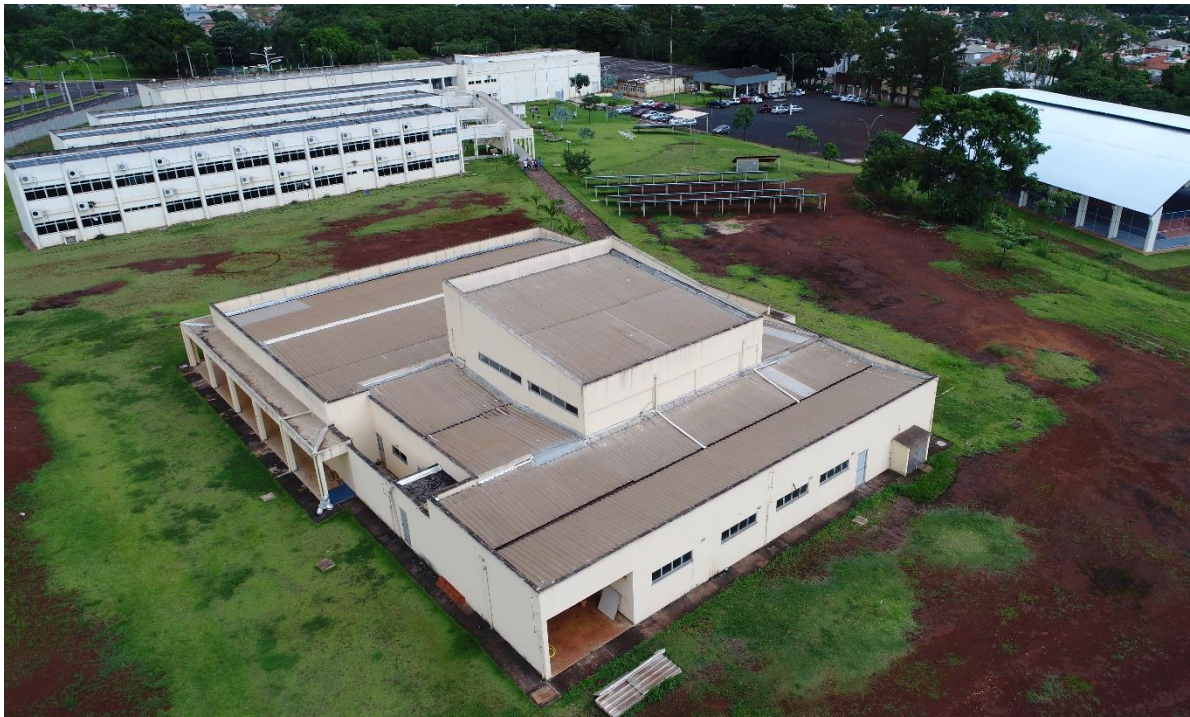
Figura 47: Visualização do Refeitório e das outras estruturas do IFG - Campus Itumbiara .
