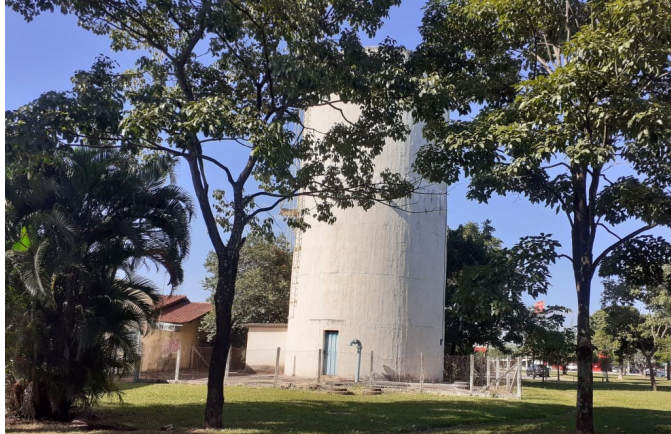
Figura 37 – Equipamento de infraestrutura implantado no imóvel 02 – Grupo 01.
