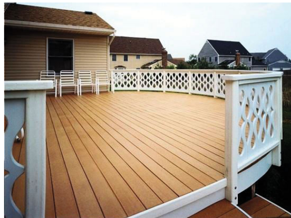
Figura 7: Deck Modular feito em Madeira Plástica
