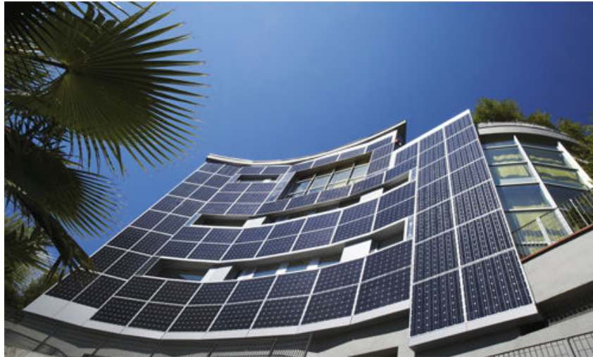
Figura 1: Painéis fotovoltaicos na fachada de um prédio
