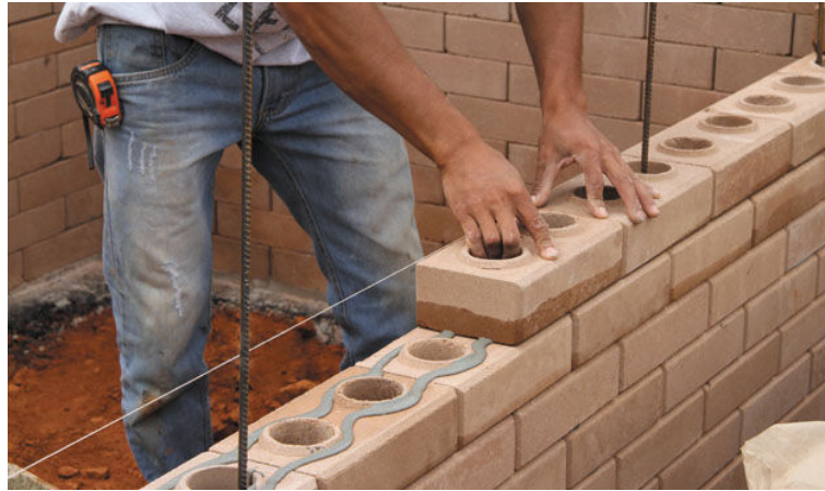
Figura 5: Assentamento de tijolo ecológico
