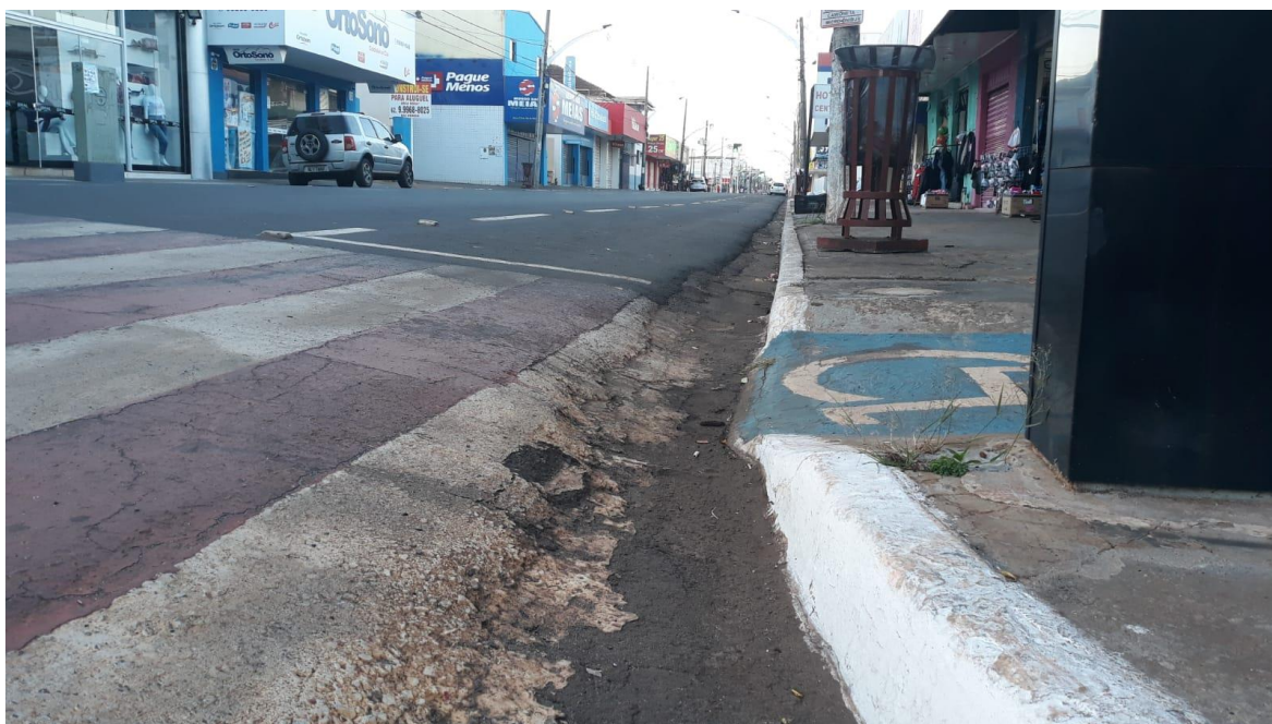
Figura 4.1.9: Desnível entre rebaixamento e leito carroçável.
