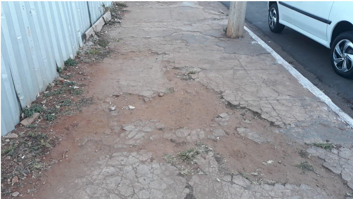
Figura 4.1.6: Material da calçada no trecho 1B.
