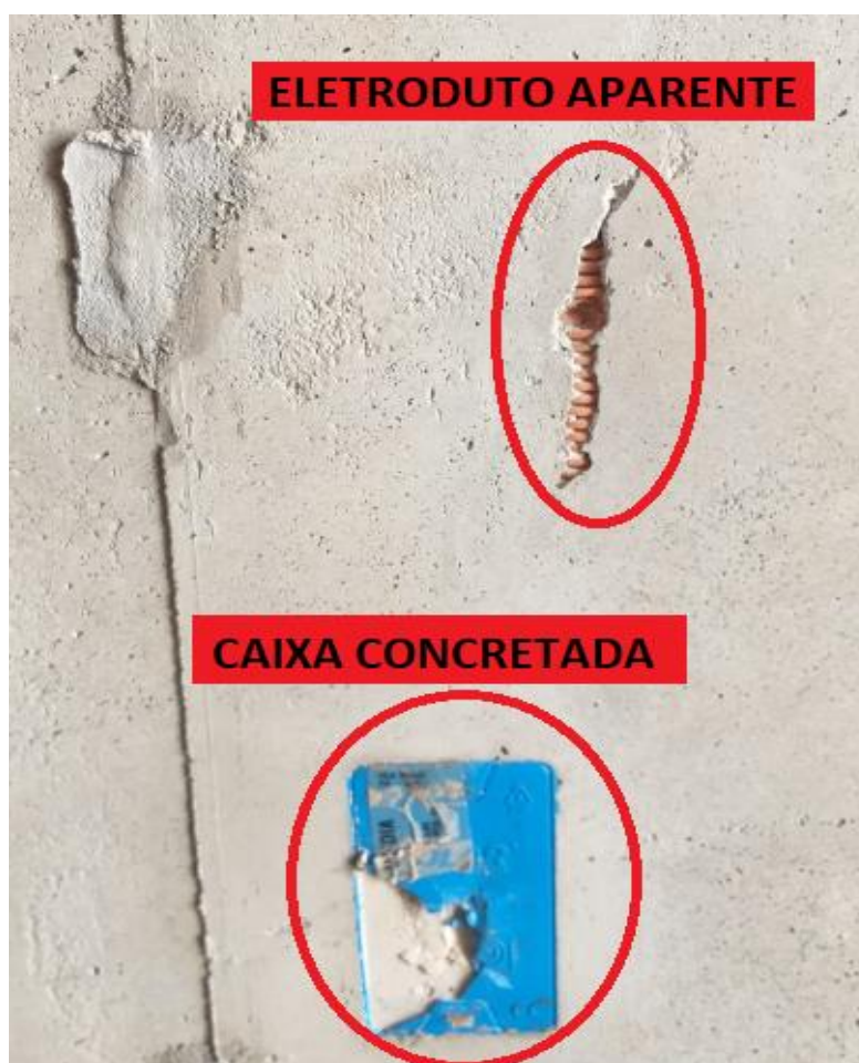
Figura 4.4.2.4 – Eletroduto aparente
