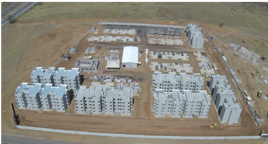
Figura 2.2.1 – Vista aérea de obra de Paredes de Concreto
