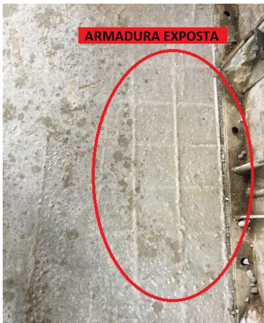
Figura 4.4.4.1 – Armadura exposta
