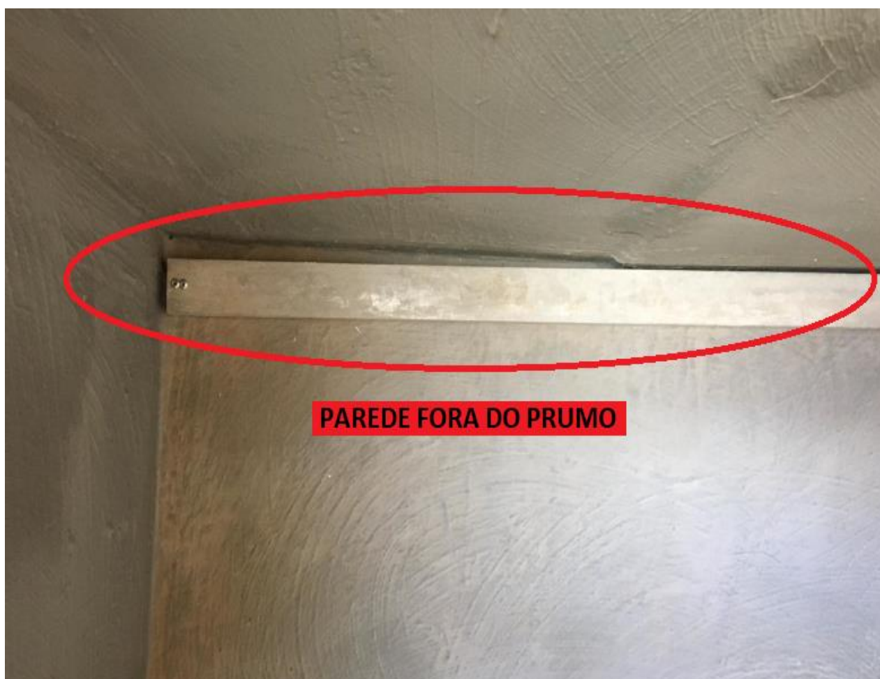
Figura 4.4.3.2 – Parede desnivelada
