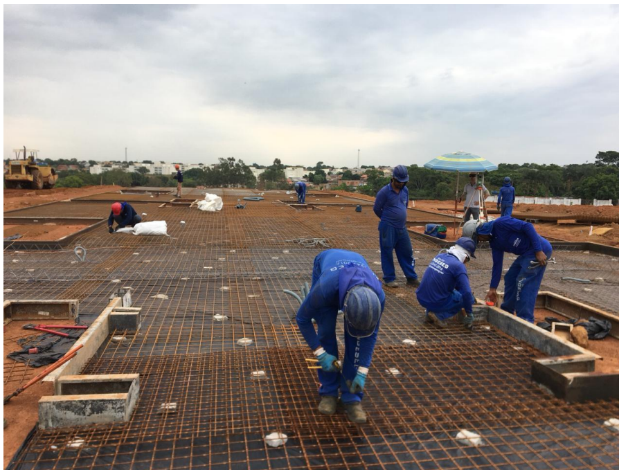
Figura 2.4.1 – Execução da armação do radier
