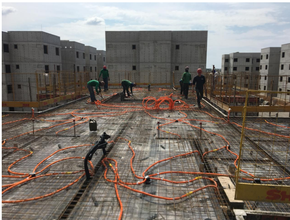
Figura 2.5.4.1 – Armaduras positiva e negativa de laje
