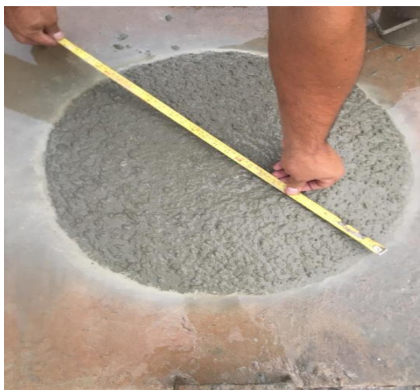
Figura 2.8.8.1.3 – Medição do espalhamento do concreto
