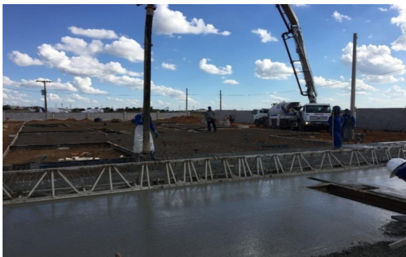
Figura 2.6.3.1 – Nivelamento piso radier
