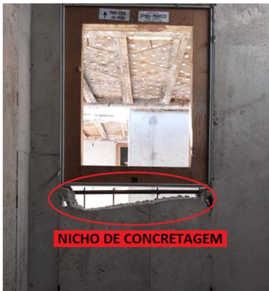
Figura 4.4.5.4 – Nicho de concretagem
