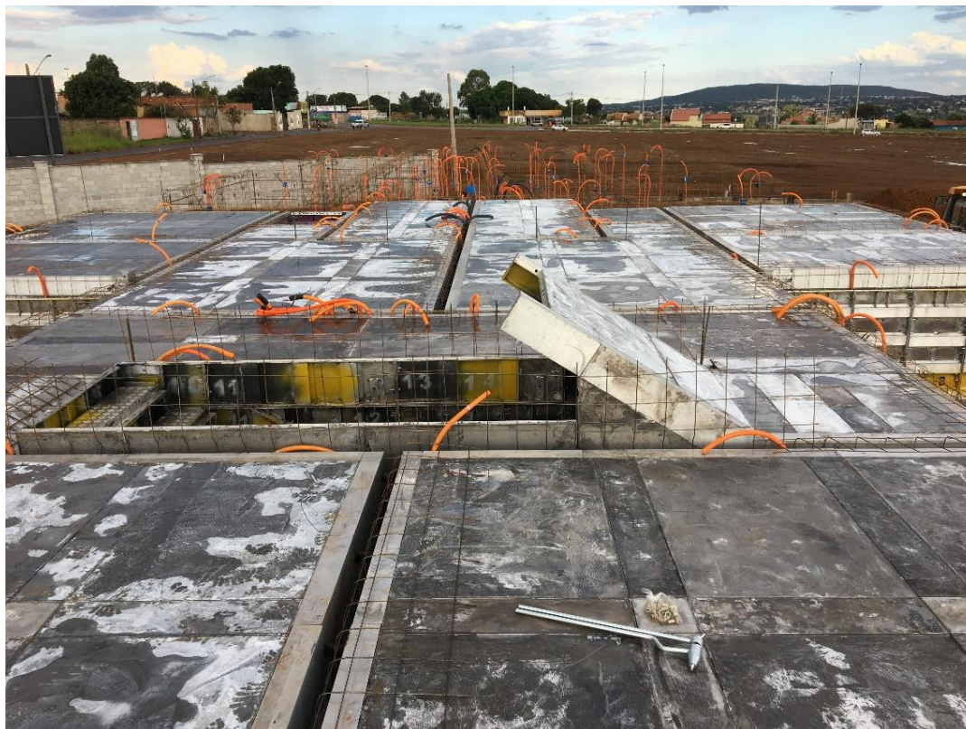
Figura 2.6.3.5 – Fechamento da fôrma de parede
