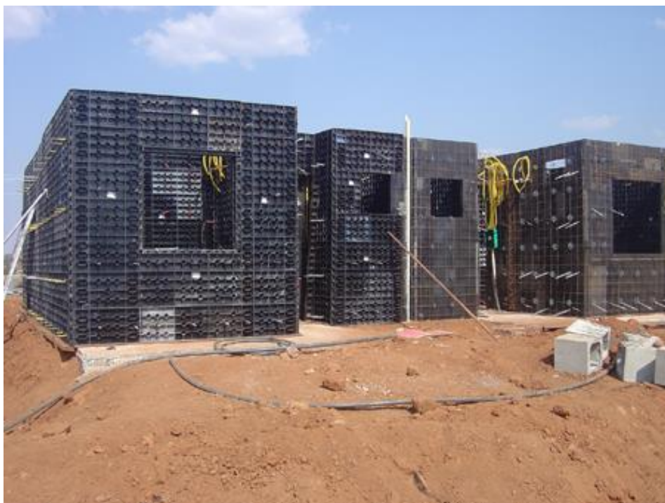
Figura 2.6.1.1 – Fôrma de plástico
