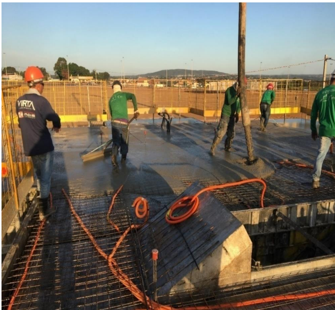
Figura 4.2.4.5 – Concretagem da laje
