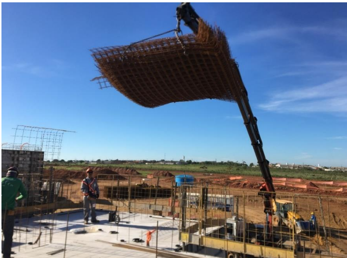
Figura 4.2.1.5 – Transporte de telas da armadura da parede
