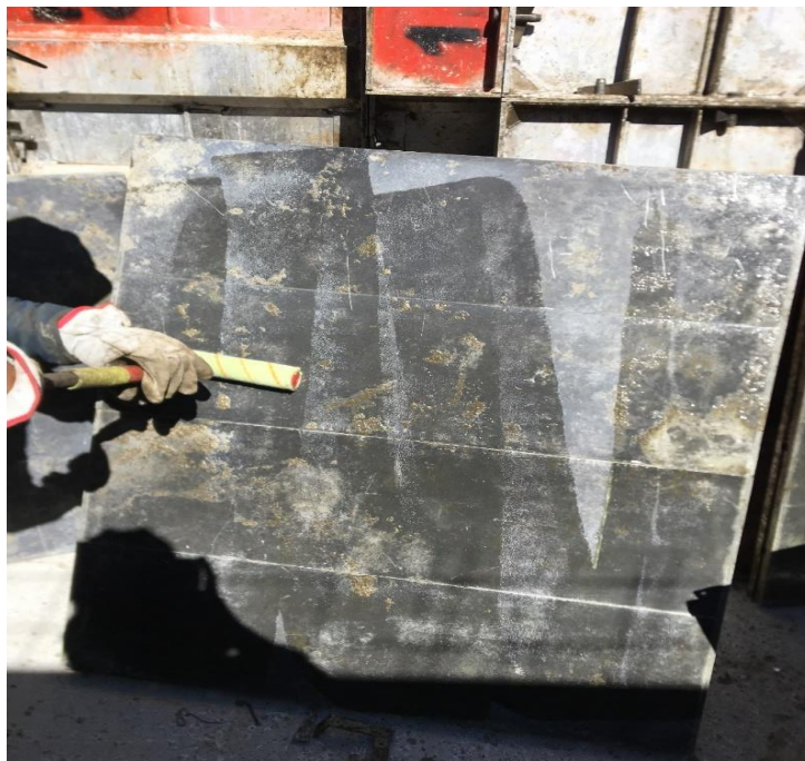
Figura 4.2.2.2 – Aplicação do desmoldante nos painéis
