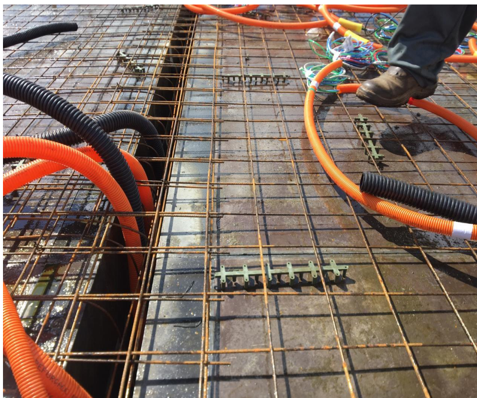
Figura 4.2.3.3 – Montagem da armação positiva
