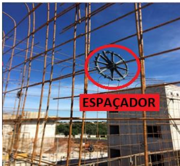
Figura 4.2.1.7 – Instalação dos espaçadores de parede
