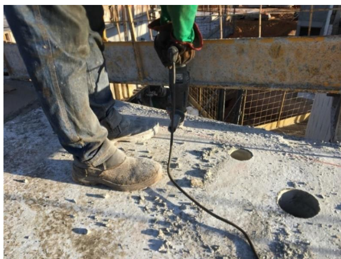
Figura 4.2.1.2 – Perfuração da laje para fixação dos arranques
