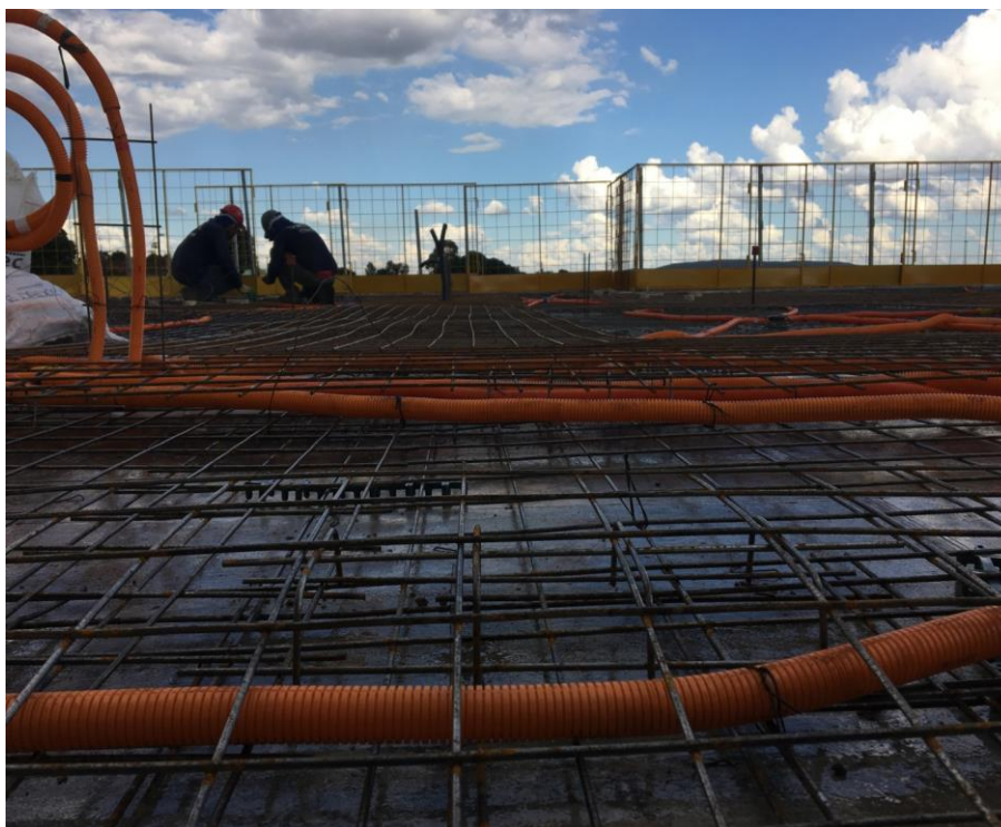
Figura 4.2.3.4 – Montagem da armação negativa
