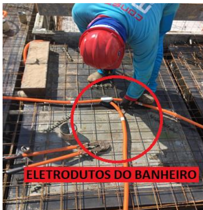
Figura 4.2.3.5 – Eletrodutos da laje
