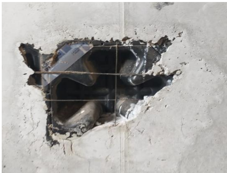
Figura 4.4.2.2 – Quadro de distribuição concretado
