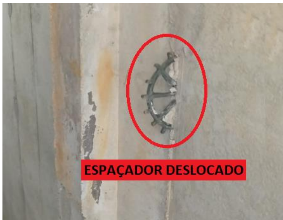
Figura 4.4.1.3 – Posicionamento dos espaçadores
