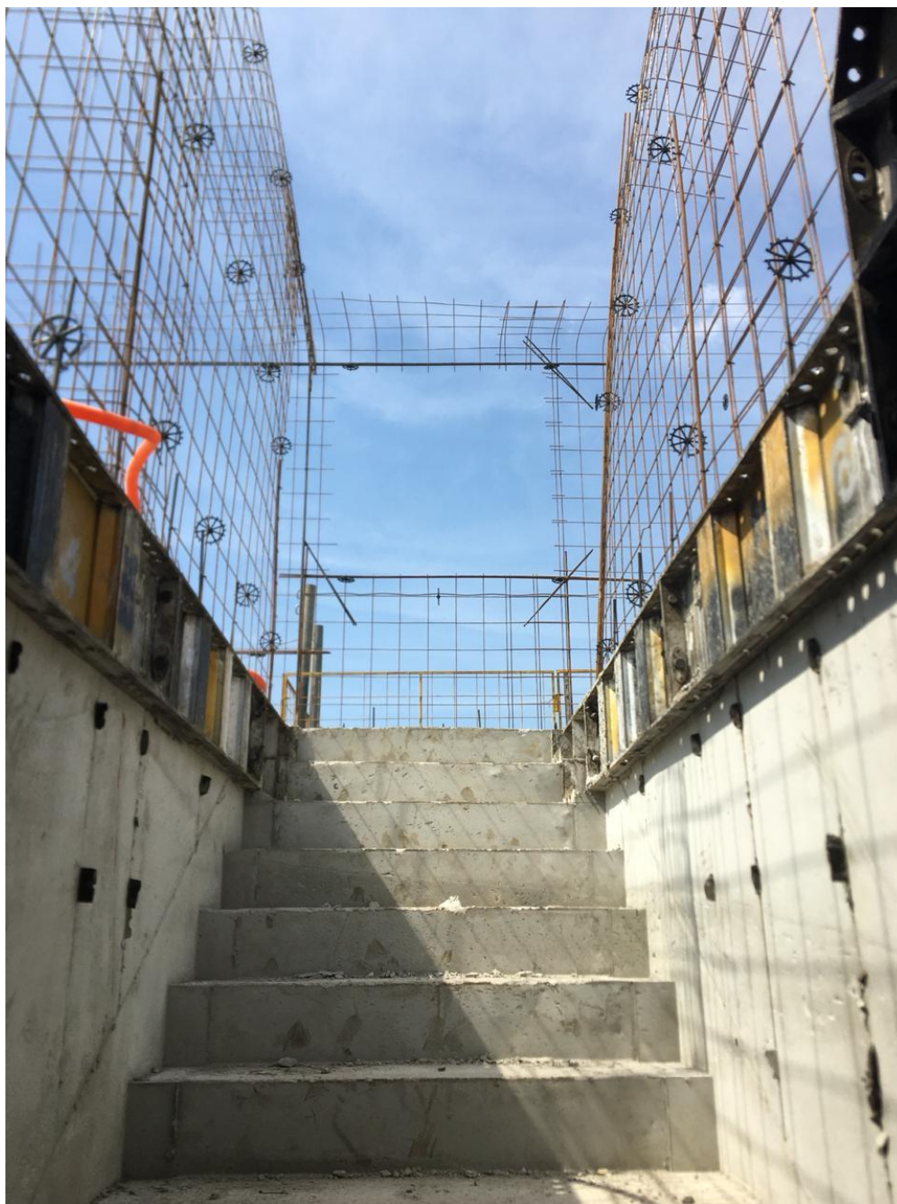
Figura 2.5.4.2 – Espaçadores em armação de parede
