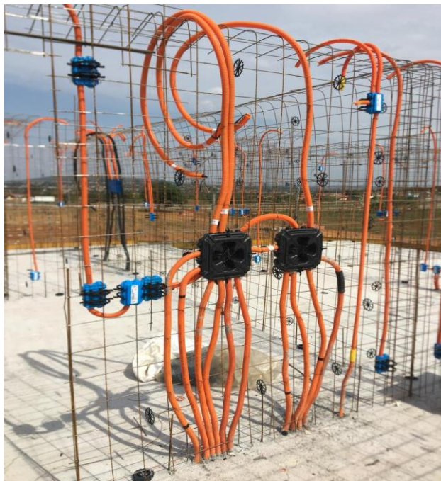
Figura 2.6.3.3 – Montagem de armadura e rede elétrica
