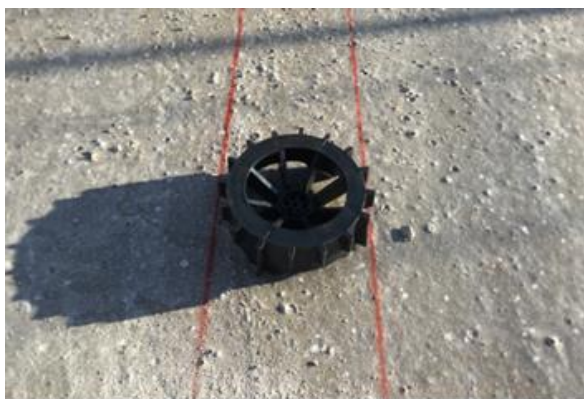
Figura 4.2.1.4 – Fixação dos espaçadores (Ø10cm)
