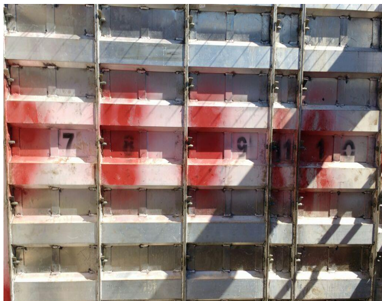
Figura 4.2.2.3 – Montagem dos painéis
