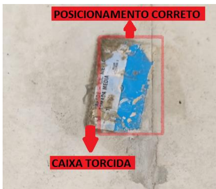
Figura 4.4.2.3 – Caixa de embutir “torcida”
