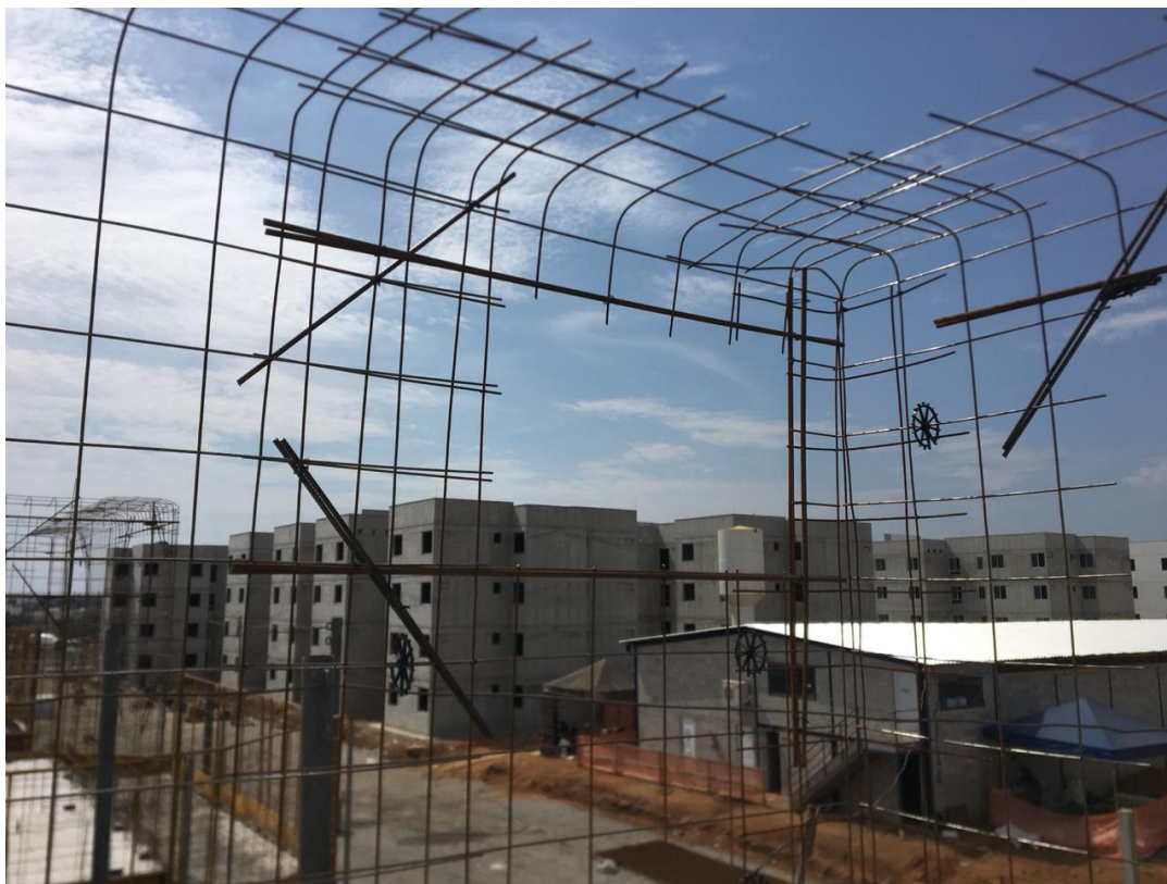
Figura 2.5.3.1 – Armadura após dobra
