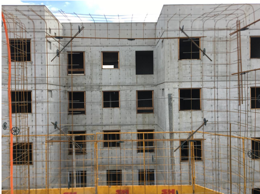
Figura 2.5.6.1 – Reforço da armadura em janela
