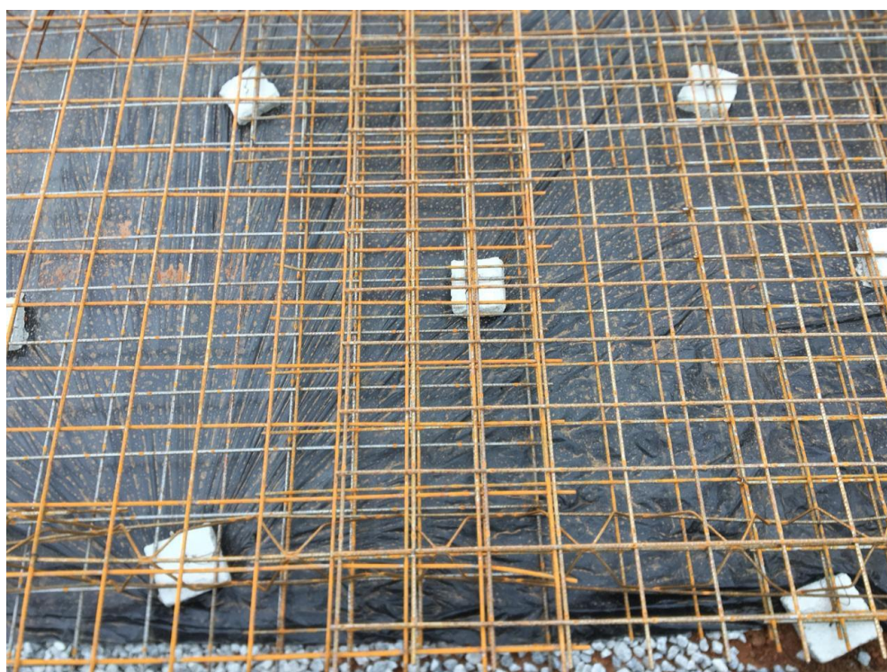
Figura 2.4.4 – Lastro de brita coberto por lona
