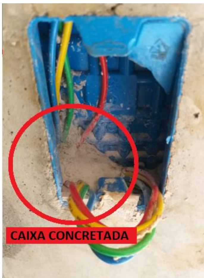
Figura 4.4.2.1 – Caixa de embutir concretada
