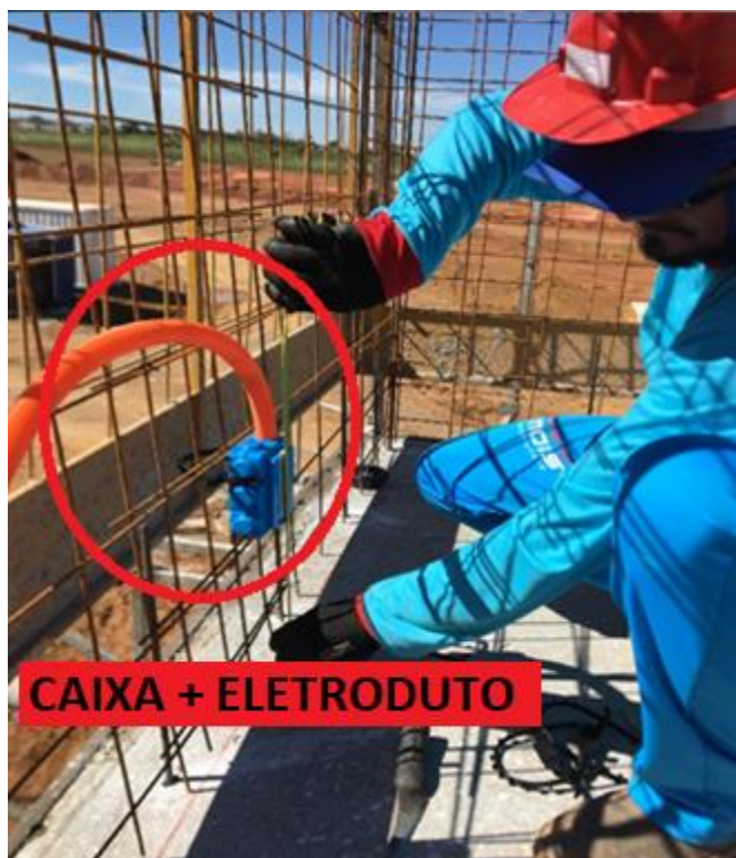
Figura 4.2.1.9 – Instalação do kit elétrico
