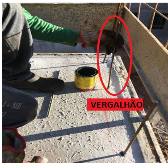
Figura 4.2.1.3 – Fixação dos arranques
