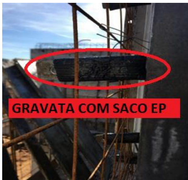
Figura 4.2.2.4 – Travamento da fôrma
