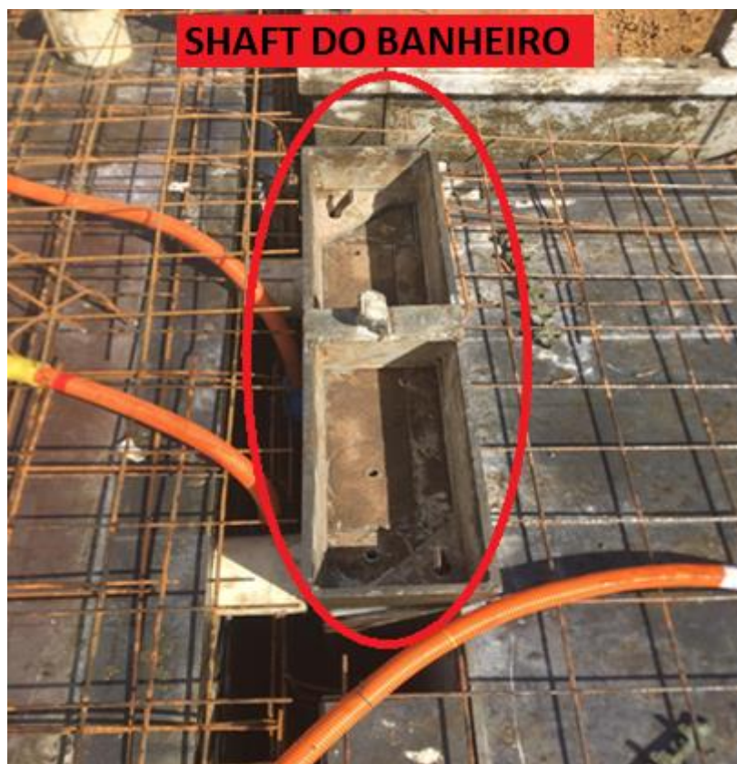
Figura 4.2.3.6 – Shafts Hidráulicos
