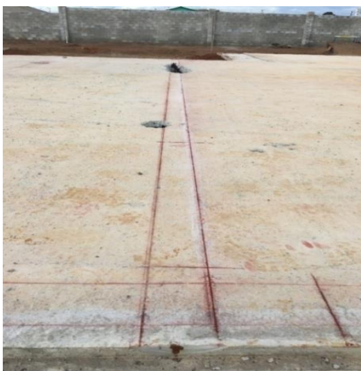
Figura 2.6.3.2 – Marcação das linhas de parede no piso de apoio
