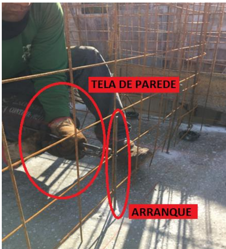
Figura 4.2.1.6 – Amarração da tela da armadura de parede
