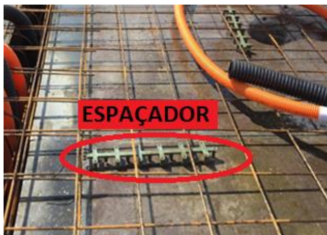
Figura 4.2.3.2 – Espaçadores centopeia para suporte da armadura positiva
