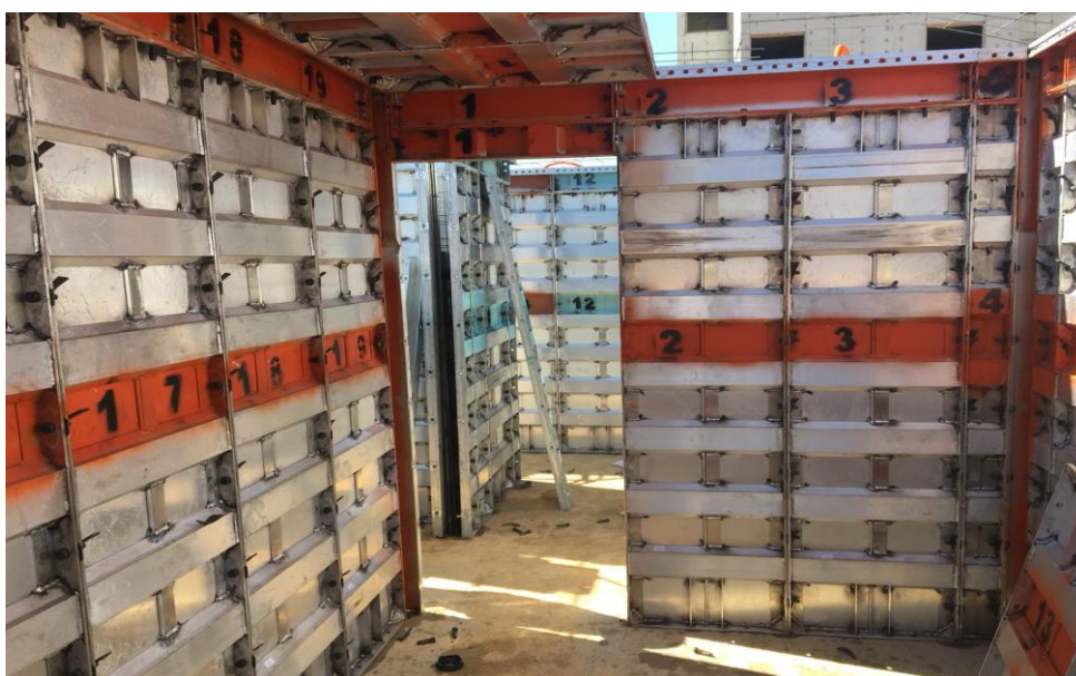
Figura 2.6.3.4 – Montagem de painéis
