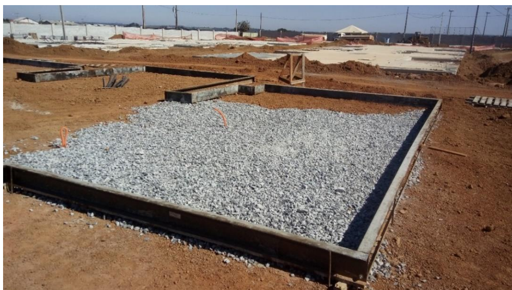
Figura 2.4.3 – Lastro de brita para regularização do solo
