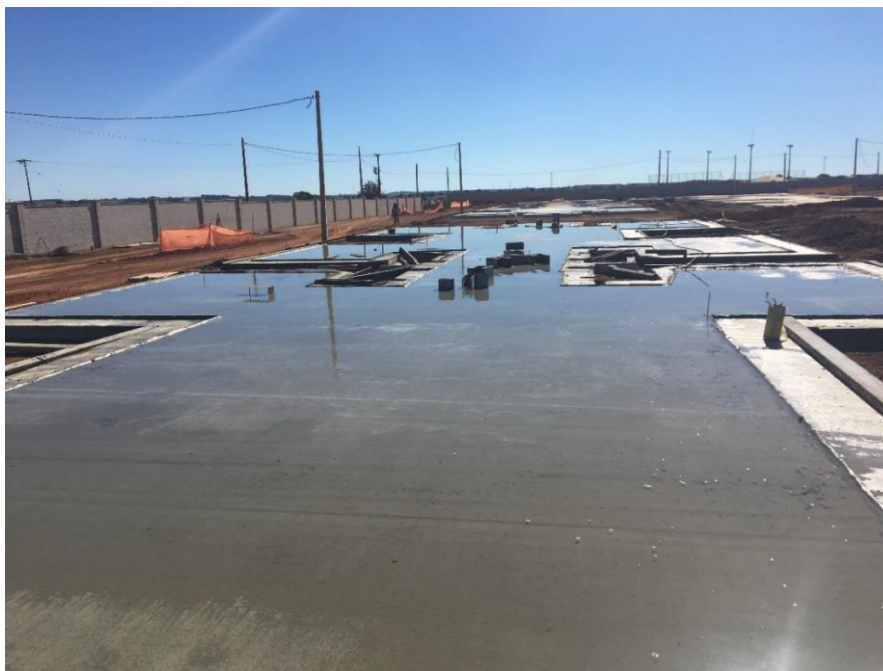
Figura 2.4.2 – Cura úmida em radier
