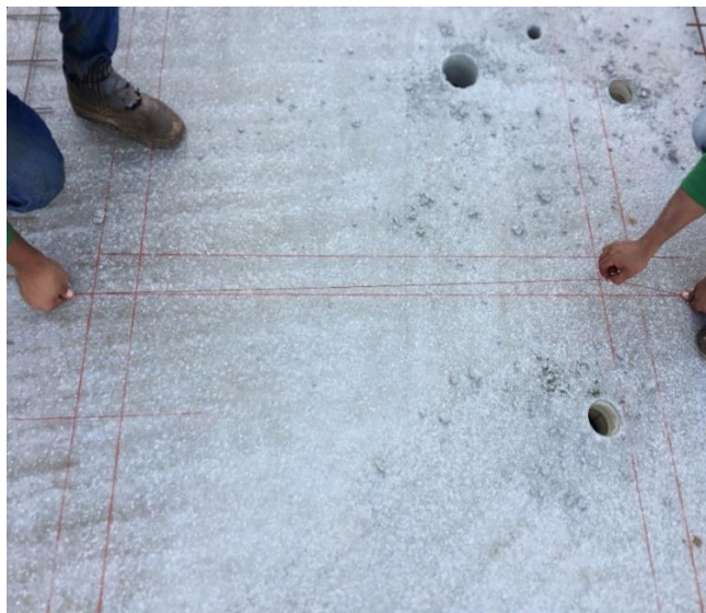
Figura 4.2.1.1 – Marcação de parede
