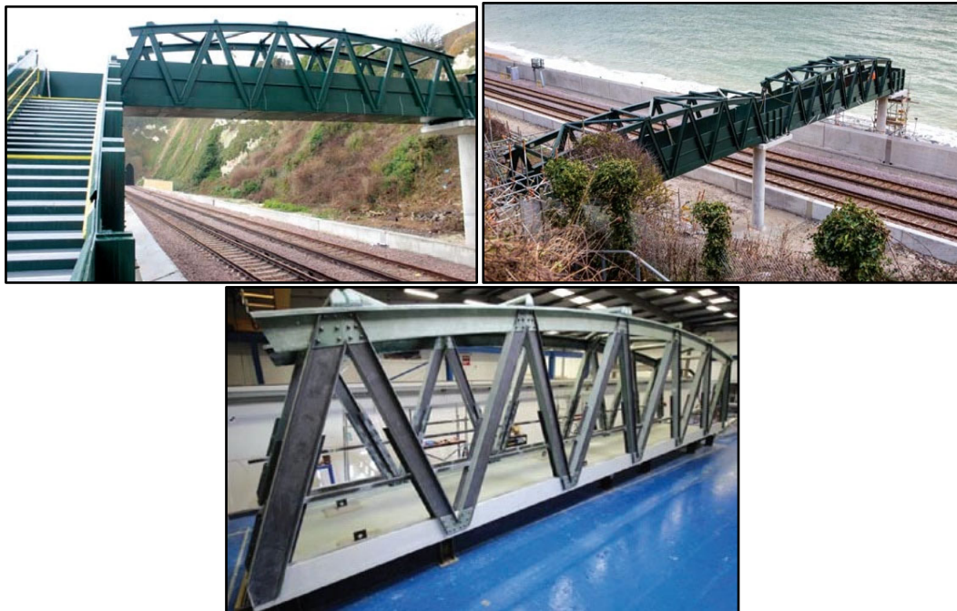
Figura 3 – Passarela em Resina reforçada com fibra de vidro sobre pilares de concreto no Dover Sea
