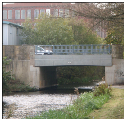
Figura 4 – Ponte sobre canal do Rio Rochdale
