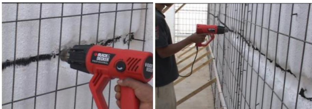
Figura 22 – Abertura de canaletas com soprador térmico
