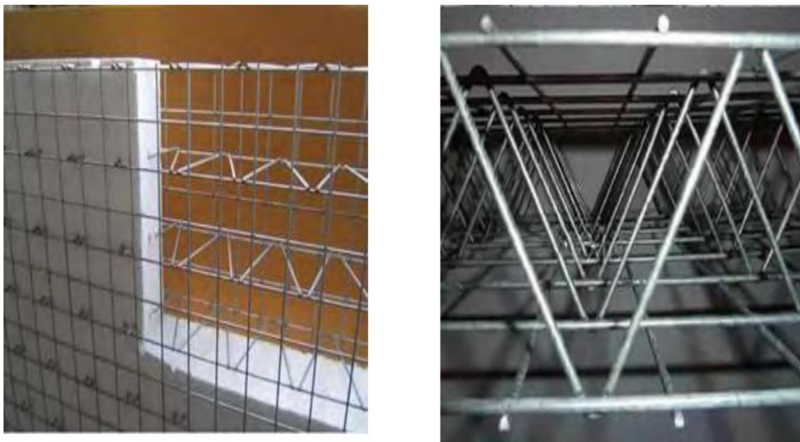
Figura 4 - Malhas de aço e os conectores horizontais entre as 2 malhas
