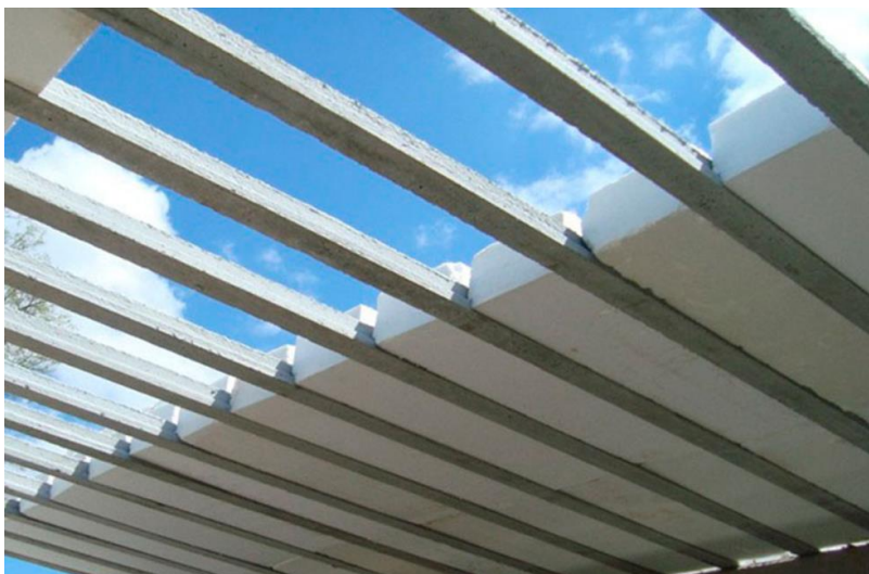
Figura 29 – Enchimento de isopor em laje aguardando concretagem
