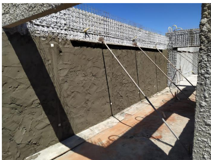
Figura 28 - Revestimento – Obra em Jataí
