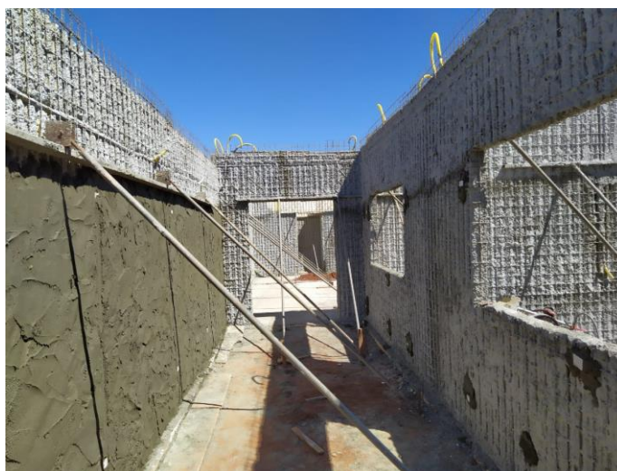
Figura 27 - Revestimento – Obra em Jataí
