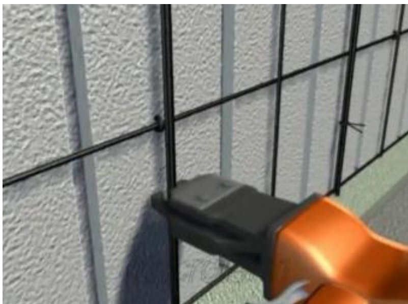
Figura 14 - Grampeador para grampos de aço para amarração dos painéis nos arranques
