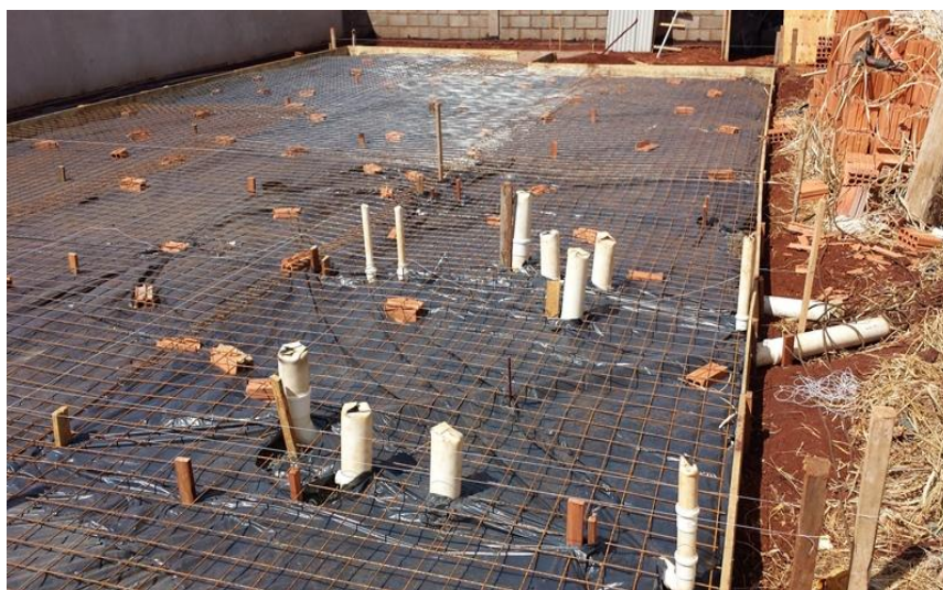
Figura 13 - Impermeabilização de baldrame com lona
