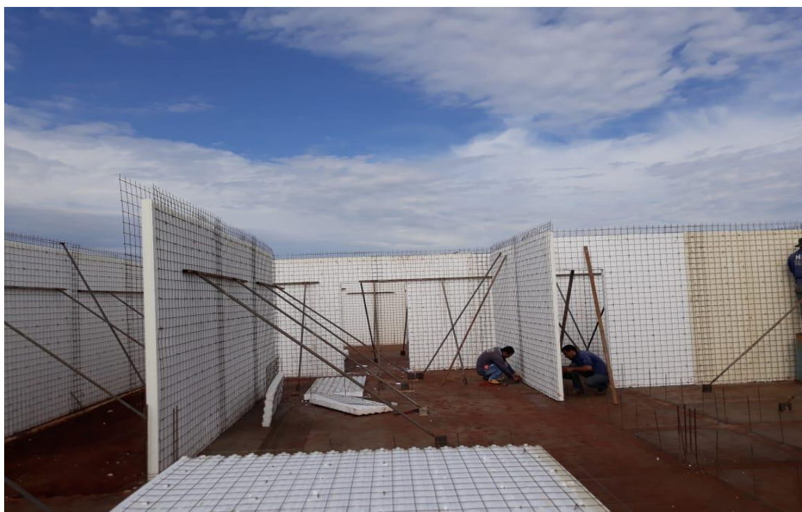
Figura 18 - Detalhe régua e escoras – Obra em Jataí
