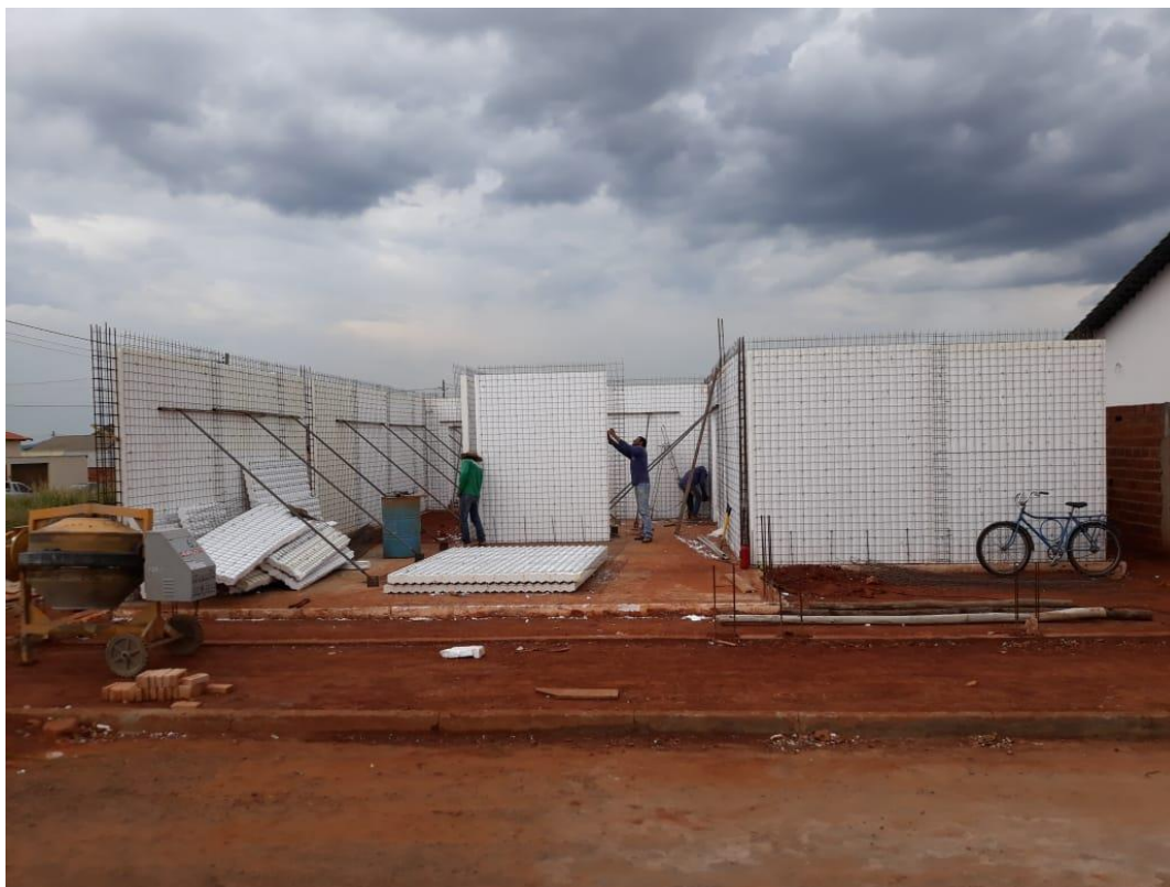
Figura 11 - Estudo de Caso – Obra em Jataí
