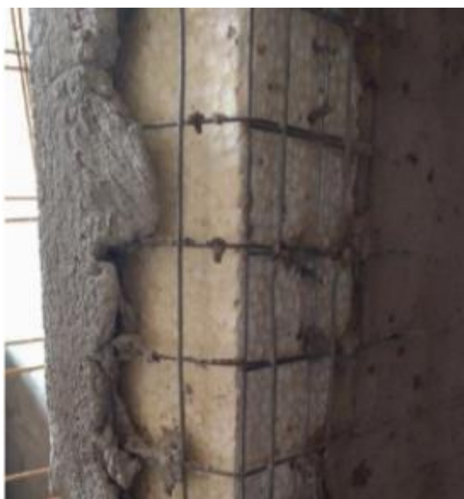
Figura 26 - Revestimento sobre painel EPS
