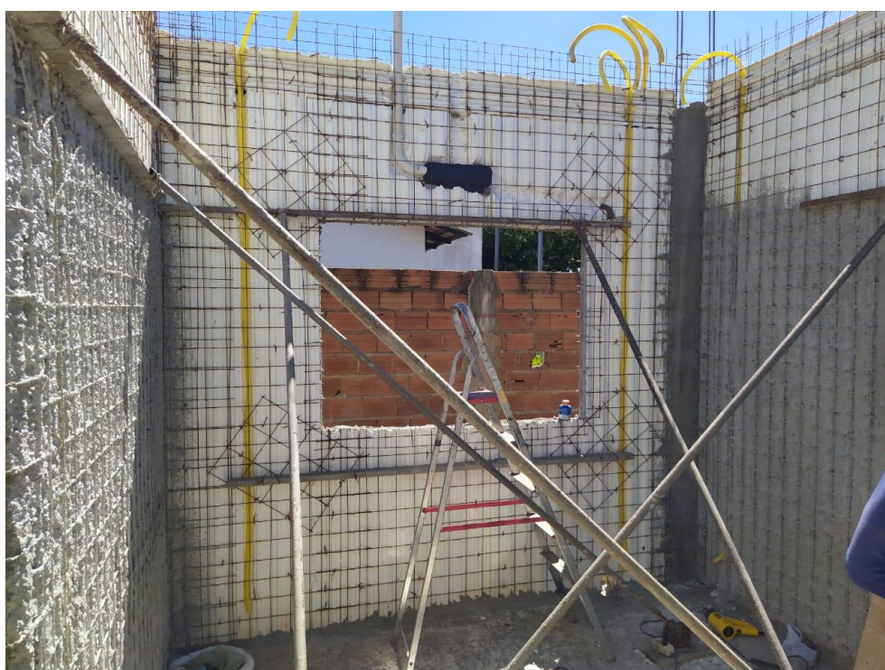
Figura 25 - Montagens e instalações dos painéis – Obra em Jataí
