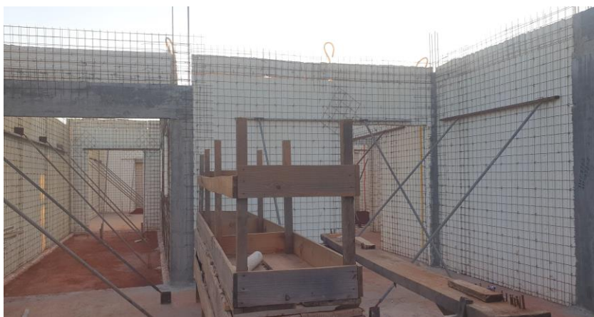
Figura 21 - Reforço entre painéis – Obra em Jataí
