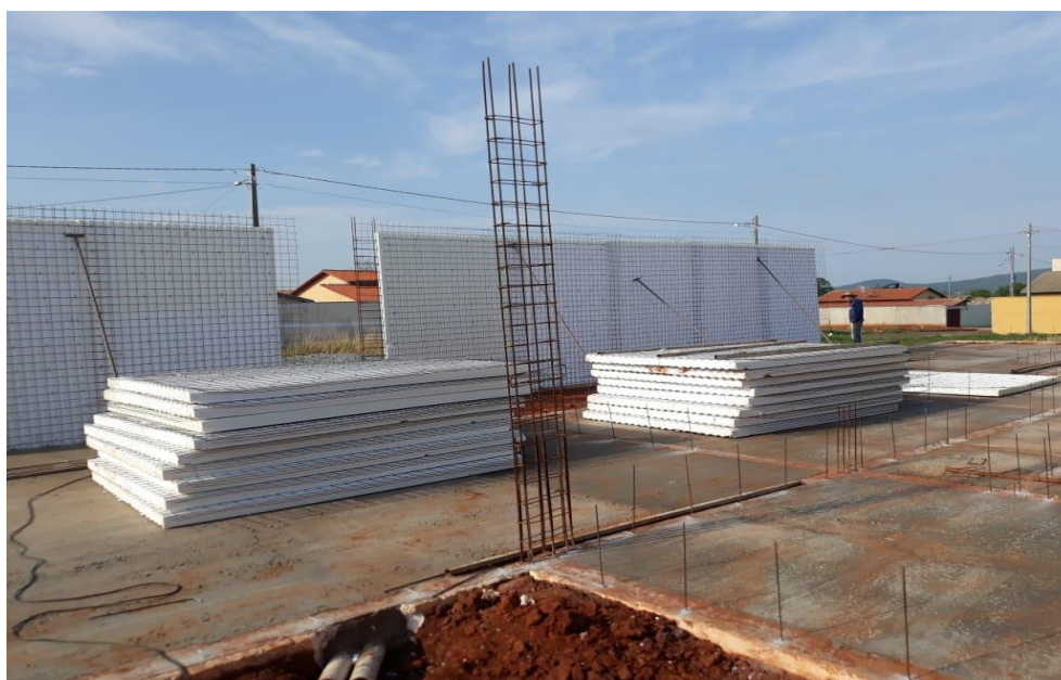
Figura 16 – Montagem dos painéis – Obra em Jataí
