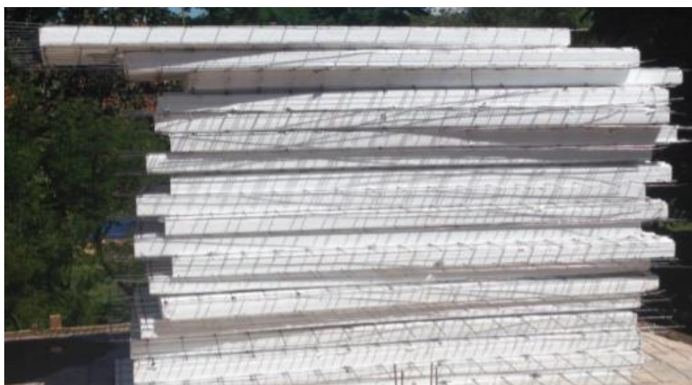
Figura 12 - Armazenamento dos painéis
