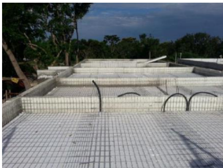
Figura 31 - Laje treliçada unidirecional de EPS
