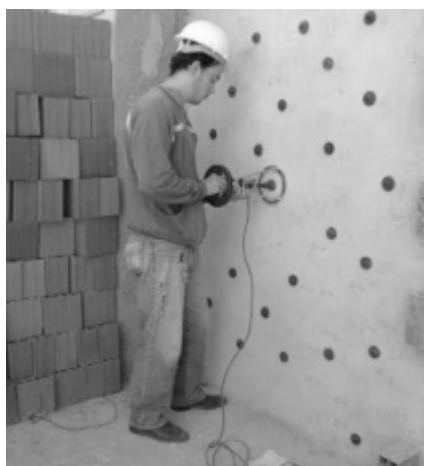
Figura 36 – Aplicação da carga no revestimento
