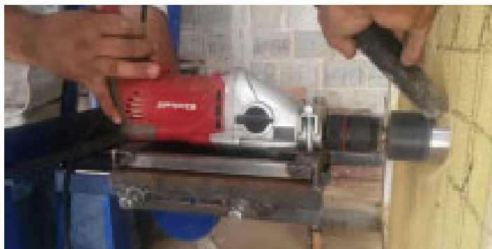
Figura 29 – Corte do revestimento com auxílio de serra copo
