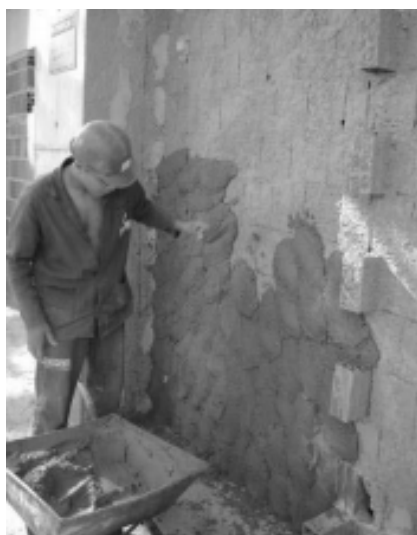
Figura 33 – Lançamento da argamassa no substrato
