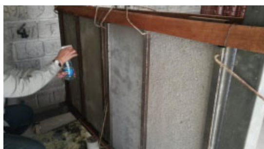
Figura 26 – Umidificação da superfície do substrato
