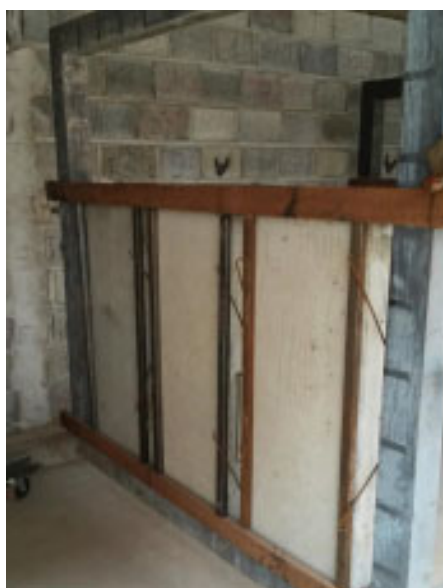
Figura 22 – Fixação dos corpos de prova no pórtico metálico
