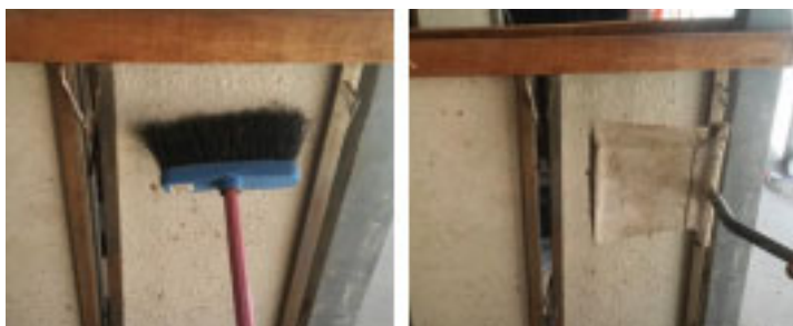
Figura 25 – Limpeza dos corpos de prova para ensaio de resistência de aderência à tração
