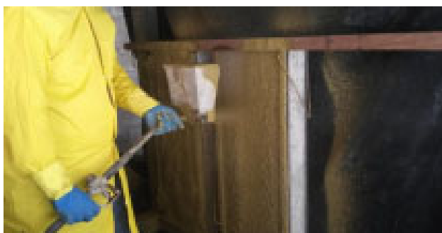
Figura 27 – Projeção de argamassa na superfície do substrato
