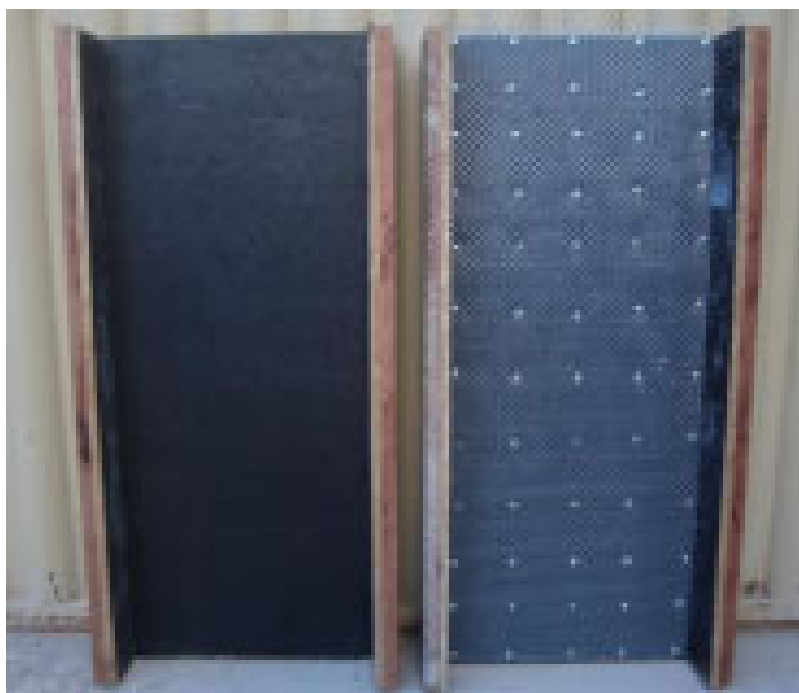
Figura 21 – Formas de compensado de madeira para painéis R1 (esquerda) e R2 (direita)
