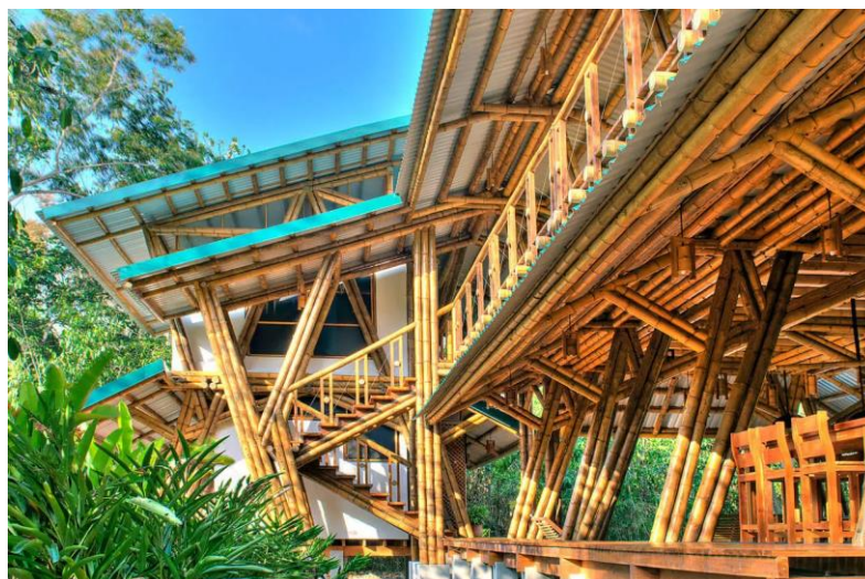
Figura 7 - Estrutura de bambu
