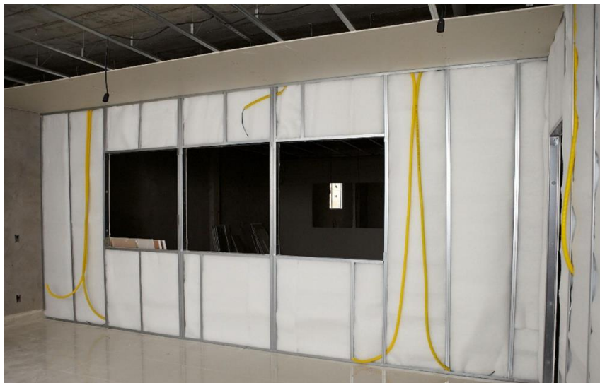
Figura 10 - Aplicação de lã de PET em sistema Drywall
