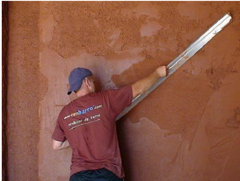
Figura 6 - Aplicação de argamassa de argila
