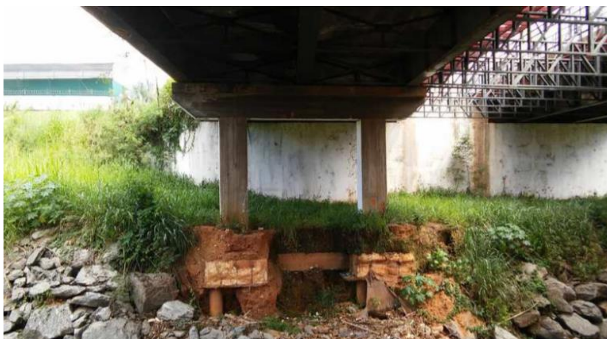
Figura 27 - Fundações da ponte da Av. T-63 vistoriada em abril de 2018.
