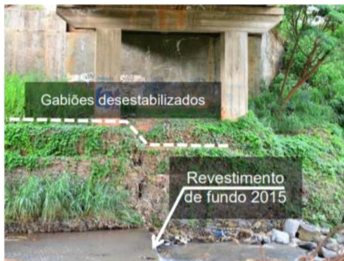
Figura 26 - Fundações da ponte da Av. T-63 vistoriada em fevereiro e 2015.
