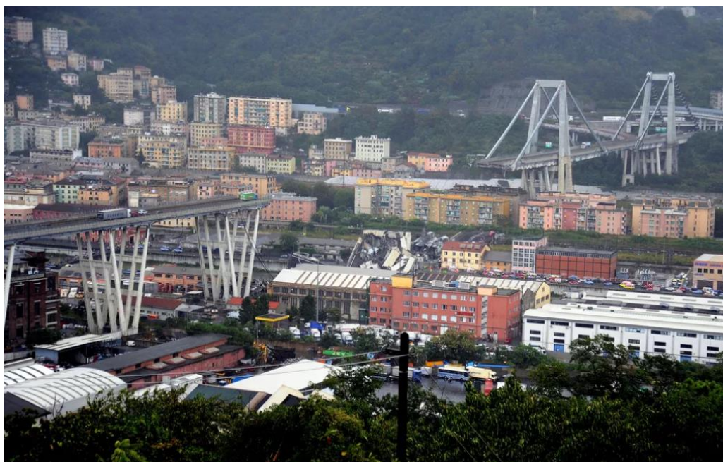
Figura 2 - Colapso da ponte Morandi em Gênova.
