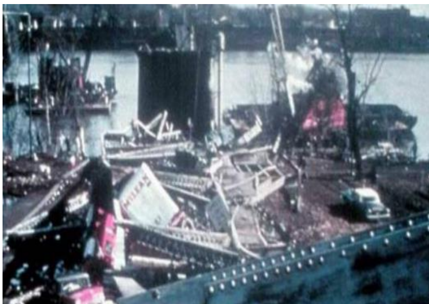
Figura 1 - Colapso da ponte Silver.
