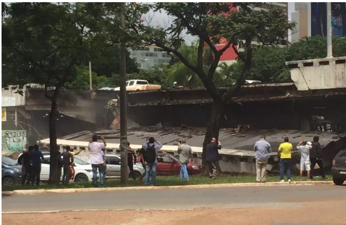
Figura 6 - Desabamento de uma pista do Eixão Sul na área central de Brasília.
