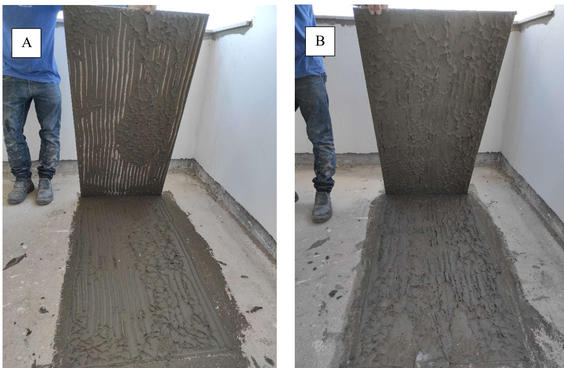
Figura 4.1 – Vista do amassamento dos cordões de argamassa das peças de porcelanato 60x120 cm assentadas utilizando a máquina vibratória com camada única de argamassa (A) e camada dupla (B).
