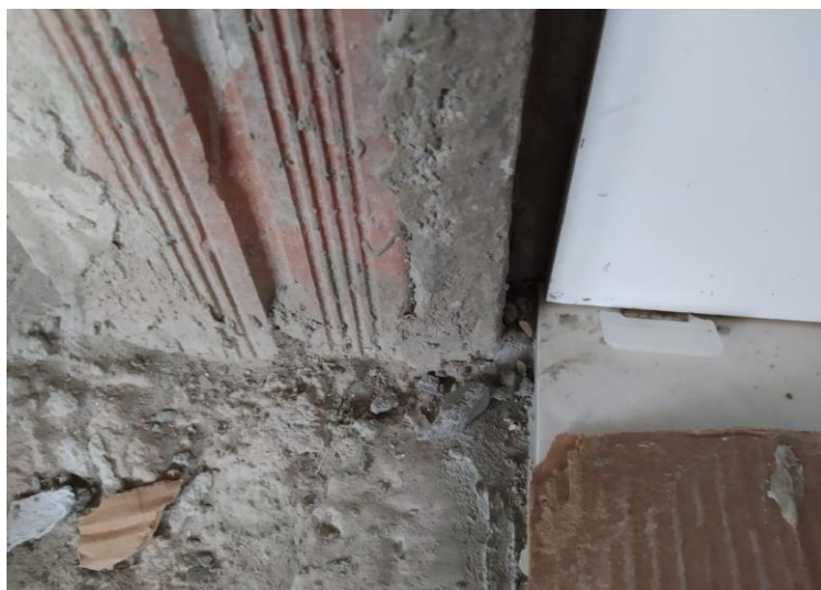
Figura 4.9 - Juntas de dessolidarização no CO-B.
