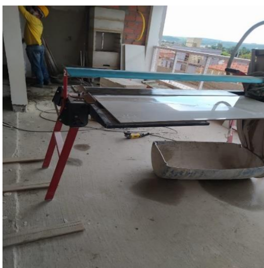
Figura 4.4 - Cortador de piso elétrico.
