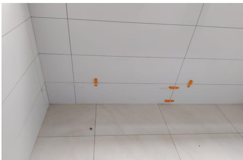
Figura 4.10 - Uso de espaçadores niveladores no CO-B.
