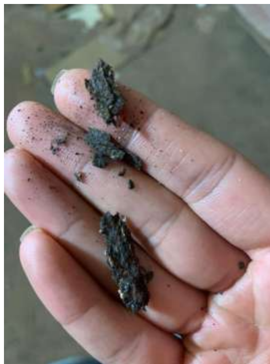
Figura 4.5 - Corrosão do aço.
