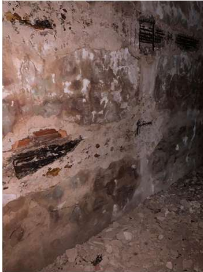
Figura 4.7 - Escareamento das vigas e pilares.
