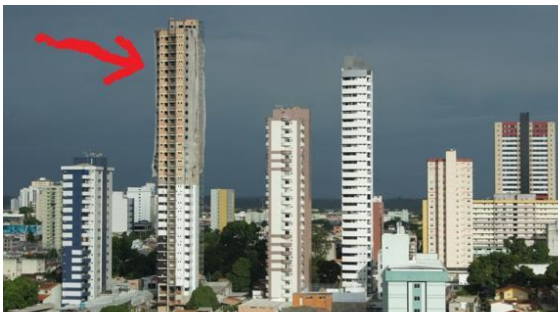
Figura 1 – Edifício Real Class pouco antes do desabamento.
