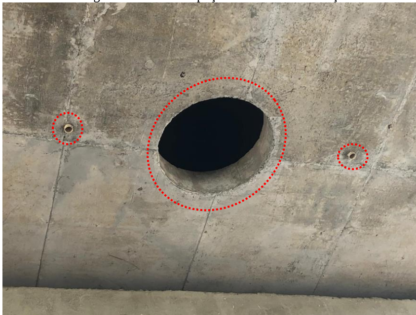
Figura 66 – Drenos e poço de vista aberto na seção caixão
