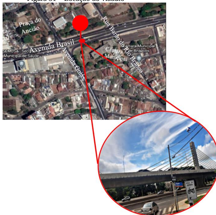
Figura 31 – Locação do viaduto
