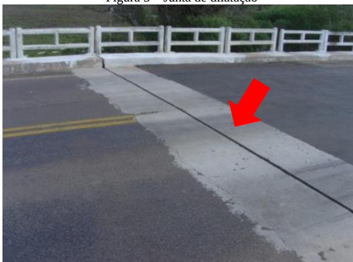
Figura 3 – Junta de dilatação
