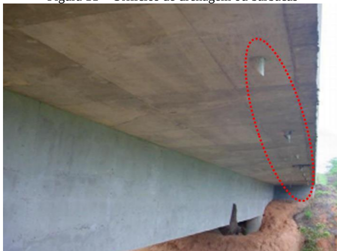
Figura 11 – Orifícios de drenagem ou barbacãs
