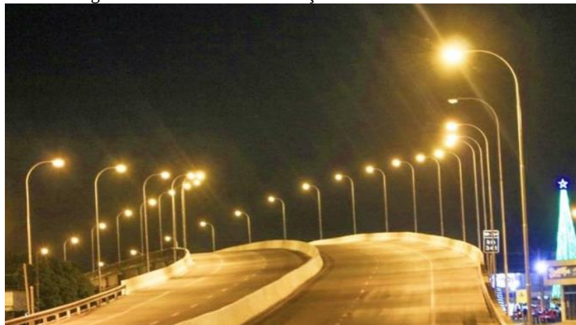
Figura 10 – Sistema de iluminação do viaduto de Ji-Paraná
