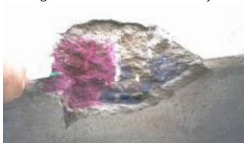
Figura 27 – Ensaio de carbonatação
