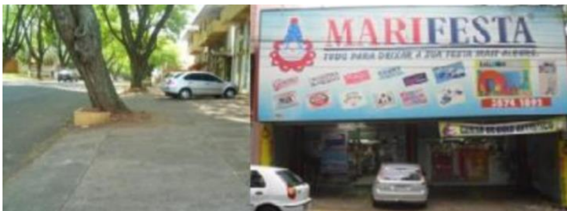
Figura 3.6 - Rebaixamento irregular das guias da calçada para estacionamento privado
