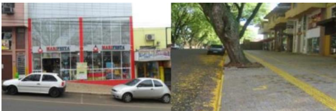
Figura 3.7 – Adequação das guias da calçada
