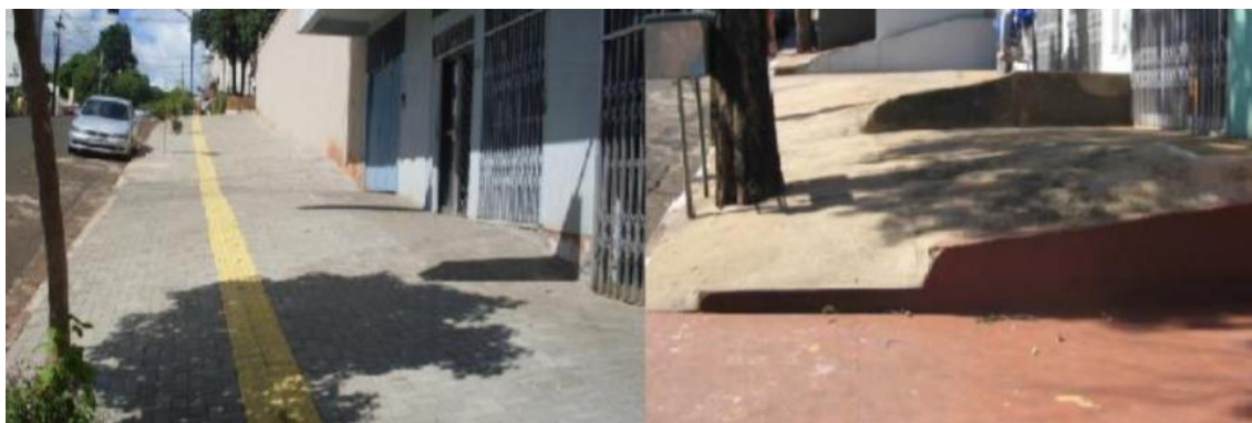
Figura 3.8 – Antes e depois da readequação de desníveis existentes entre imóveis
