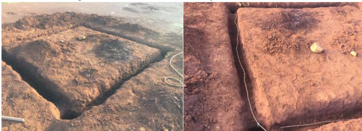
Figura 57: Malha de aterramento em quadrado vazio finalizada
