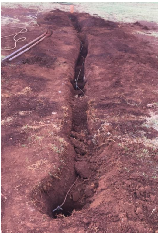
Figura 52: Topologia de hastes alinhadas com cabos e hastes inseridos no solo
