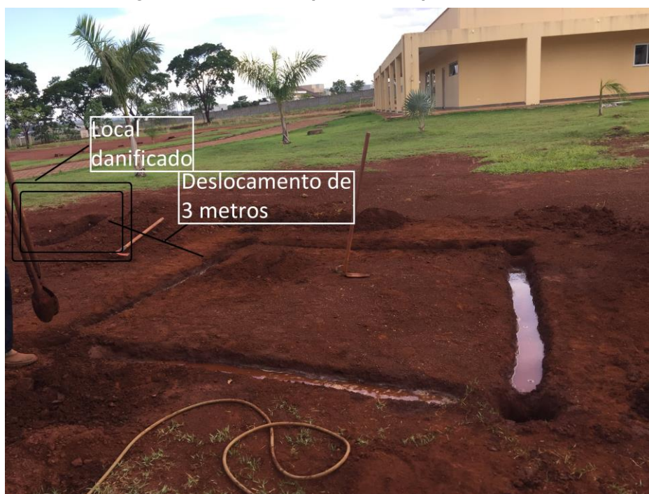
Figura 56: Novo local para malha quadrado vazio
