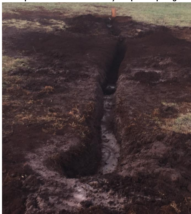
Figura 51: Resultado do primeiro dia das escavações para topologia de hastes alinhadas
