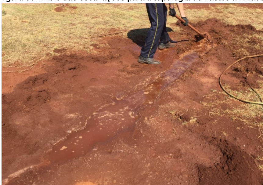
Figura 50: Início das escavações para a topologia de hastes alinhadas
