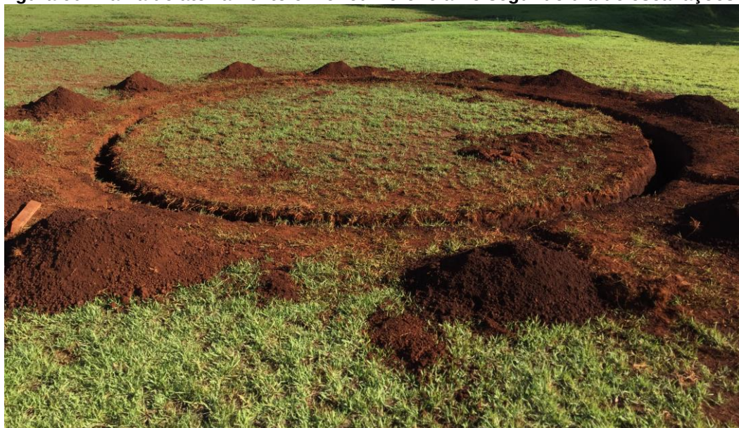
Figura 60: Malha de aterramento em circunferência no segundo dia de escavações
