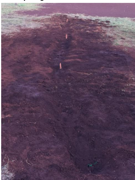
Figura 53: Topologia de hastes alinhadas finalizada
