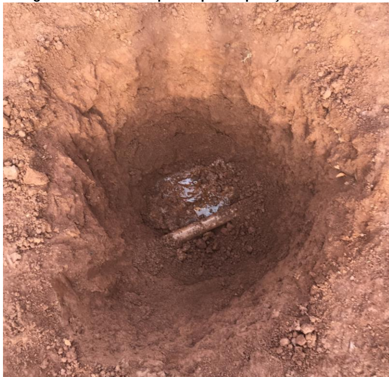
Figura 55: Buraco ampliado para reparação dos canos
