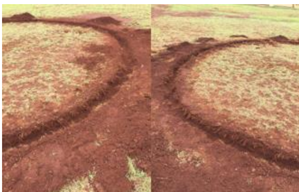
Figura 58: Malha de aterramento em circunferência sob diferentes perspectivas
