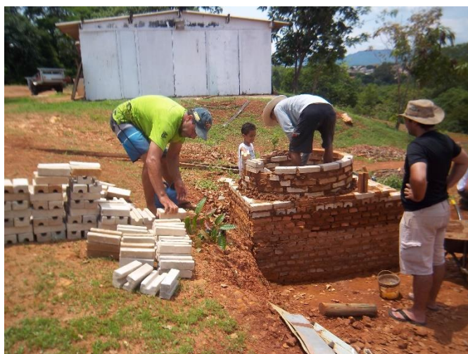
Fig. 77: Construção de forno para queima de cerâmica no IFG Câmpus Cidade de Goiás
