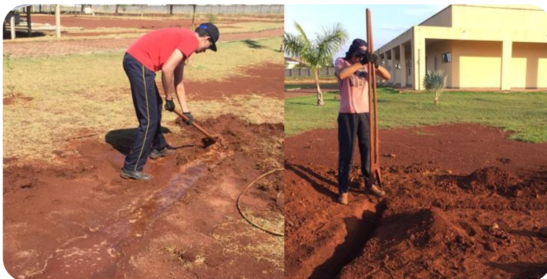
Figura 74 - Escavação das trincheiras
