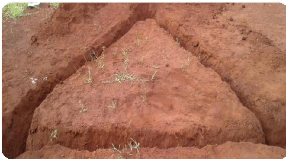
Figura 75 - Escavação em forma geométrica de triângulo
