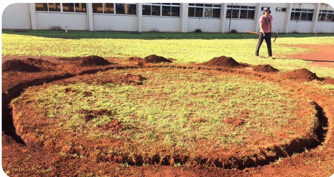
Figura 78 - Escavação em forma geométrica de circunferência
