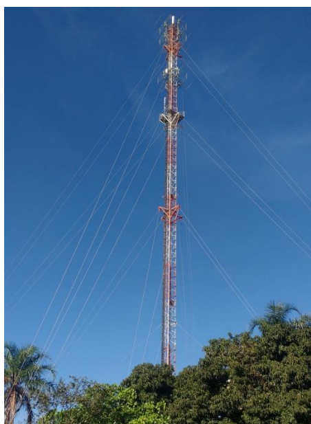
Figura 1 – Torre estaiada localizada na cidade de Jataí-GO
