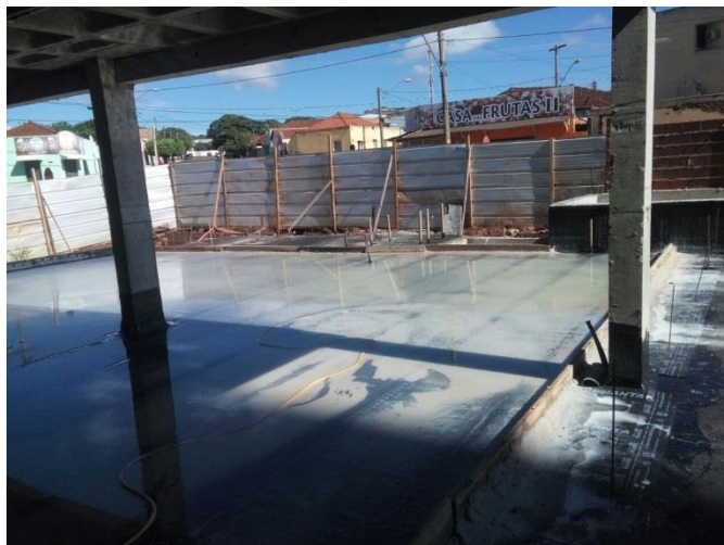
Figura 24 – Teste de estanqueidade da manta asfáltica
