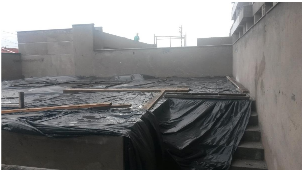
Figura 35 –Lona plástica sobre a superfície para evitar umidade
