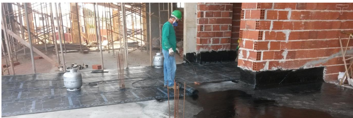
Figura 23 – Aplicação da manta asfáltica
