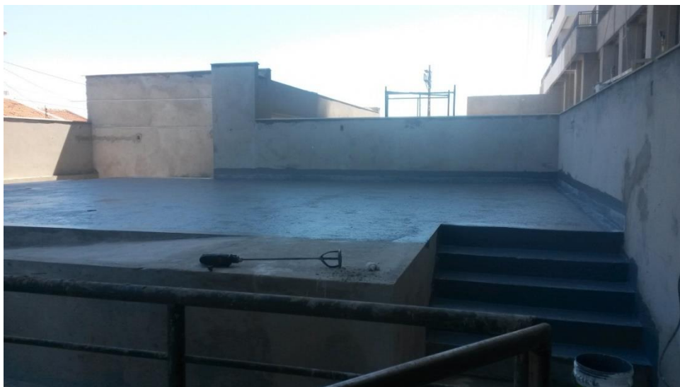
Figura 36 – Resultado após aplicação da quinta demão de poliuretano
