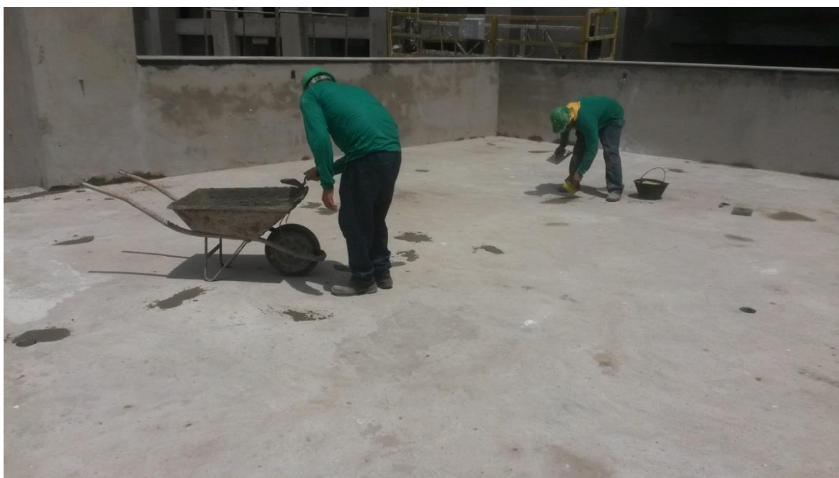
Figura 30 – Regularização da superfície
