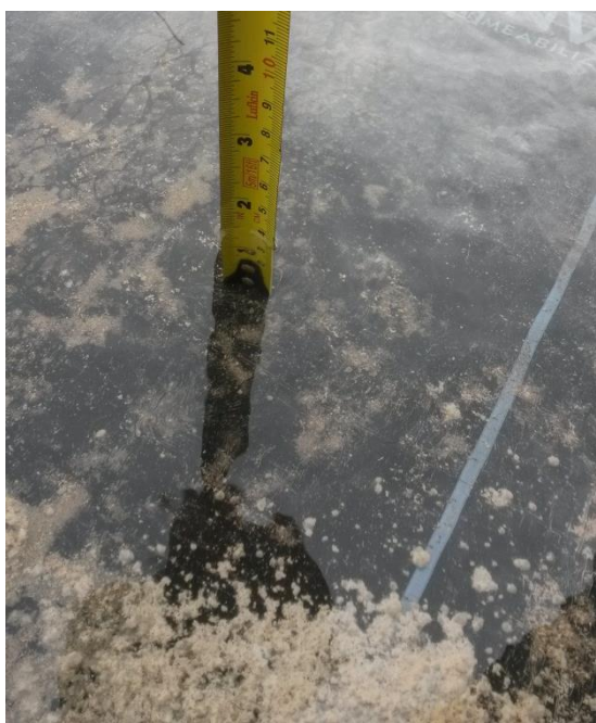
Figura 25 – Altura da lâmina d'água do teste de estanqueidade da manta asfáltica
