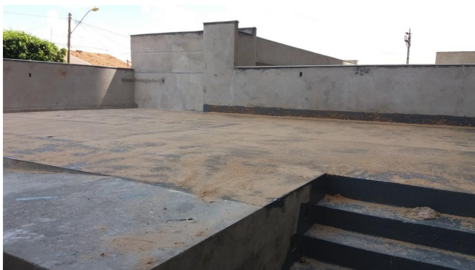
Figura 37 – Areia fina sobre a membrana de poliuretano
