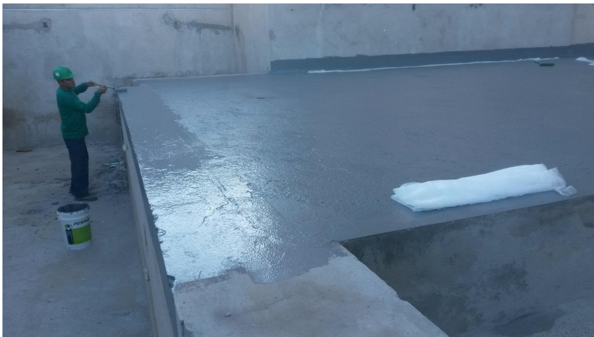
Figura 32 – Aplicação da primeira demão de poliuretano
