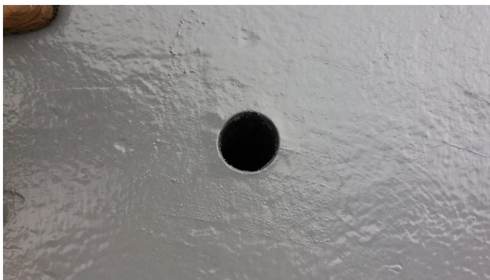
Figura 34 – Colagem da tela de poliéster nos ralos
