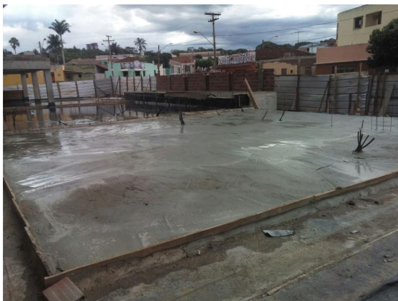
Figura 27 – Preparo da proteção mecânica sobre a camada separadora da manta asfáltica
