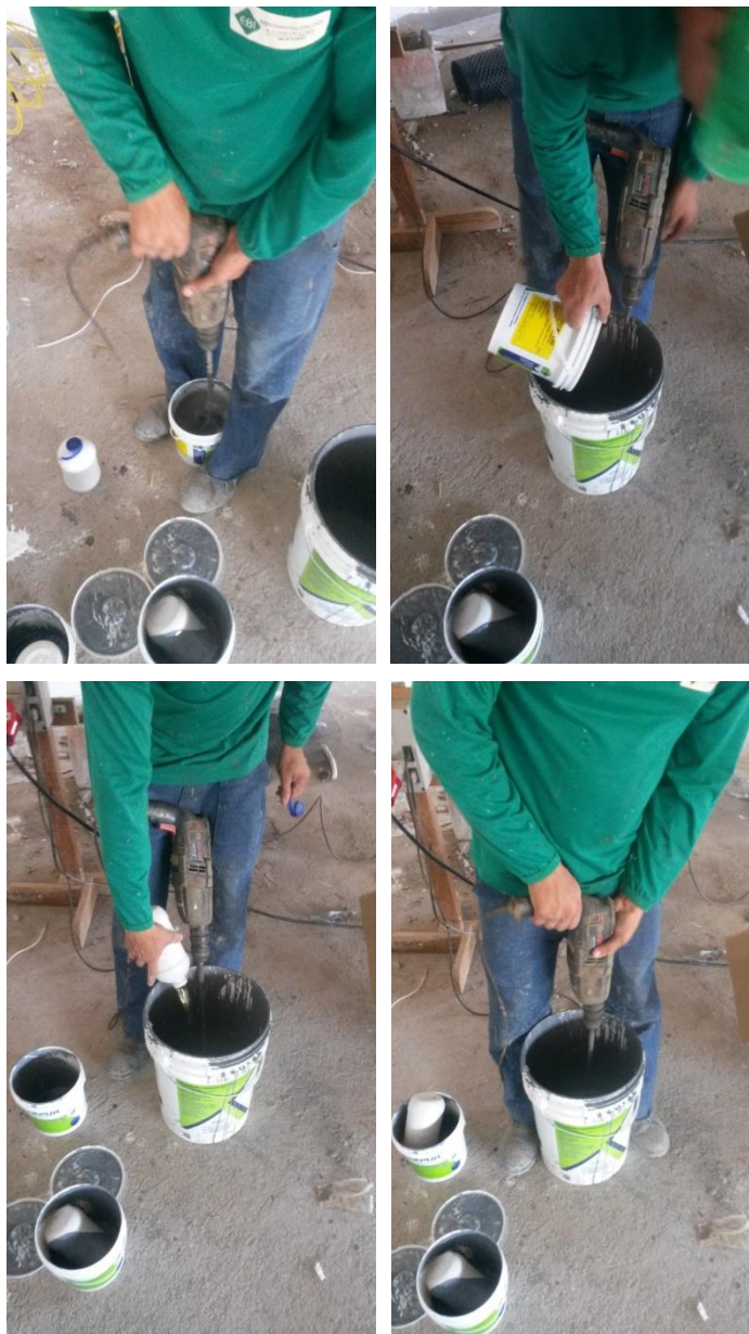
Figura 31 – Mistura dos componentes do poliuretano
