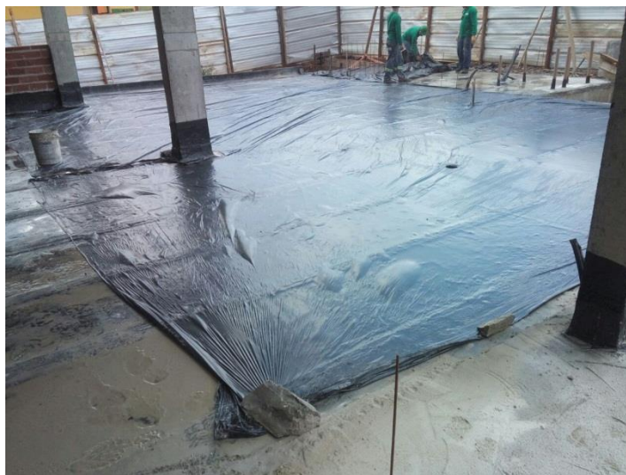
Figura 26 – Camada separadora sobre a manta asfáltica
