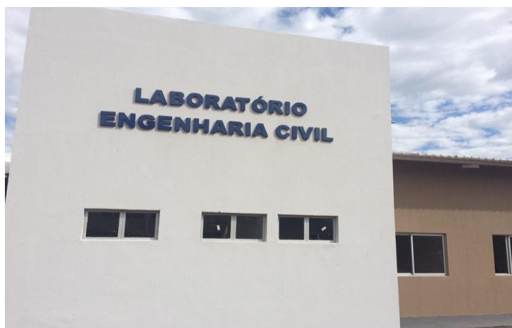
Figura 4.3 – Bloco de laboratórios do curso de Engenharia Civil
