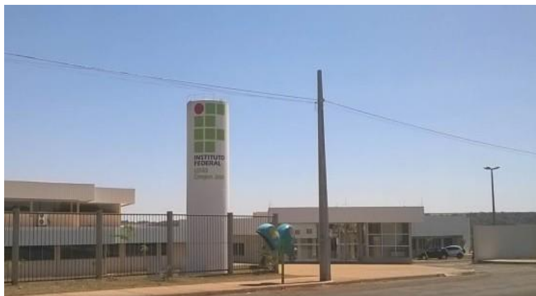
Figura 4.2 – IFG – Unidade Flamboyant
