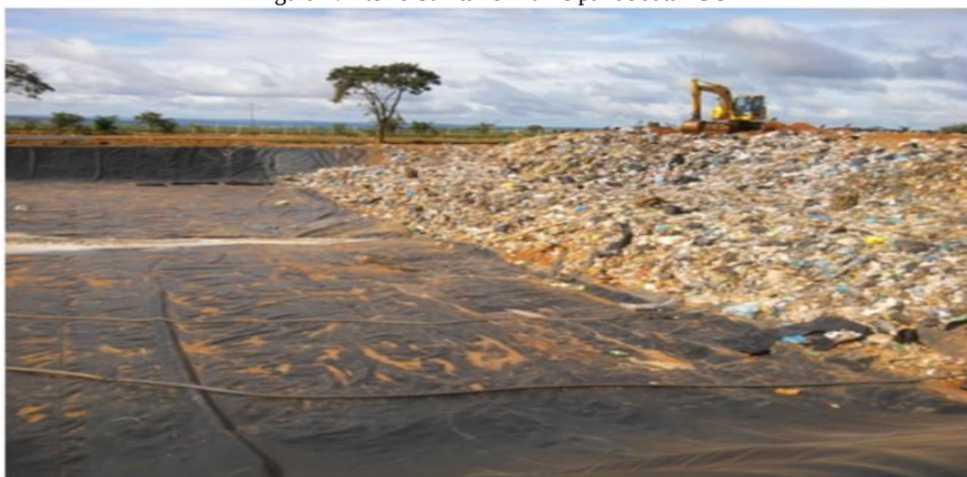
Figura 1: Aterro Sanitário Municipal de Jataí-GO
