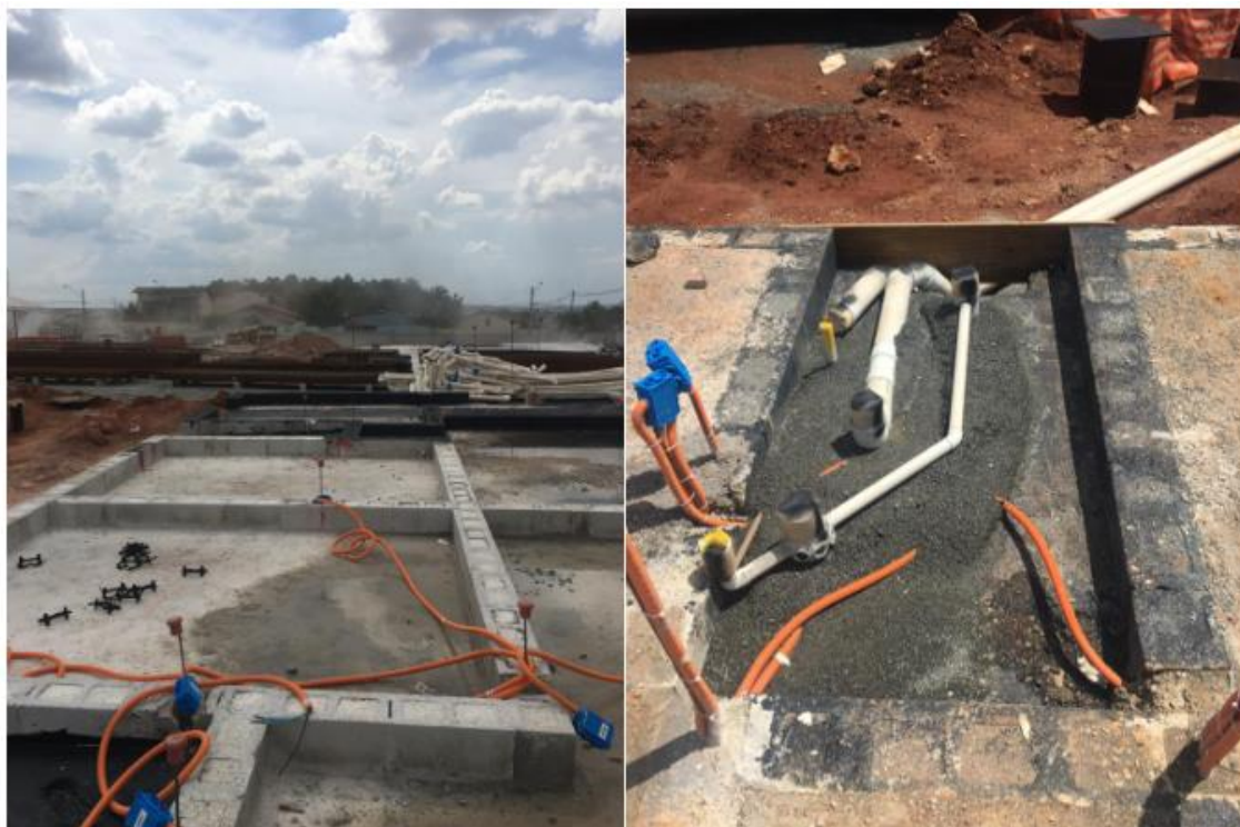
Figura 7: Instalações prediais na fiada 0
