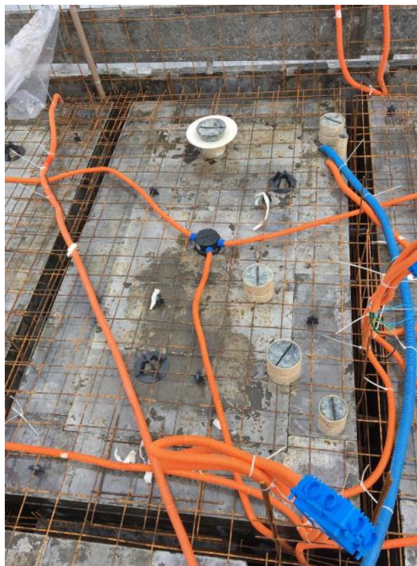
Figura 40: Fixadores e passantes posicionados na forma antes da concretagem
