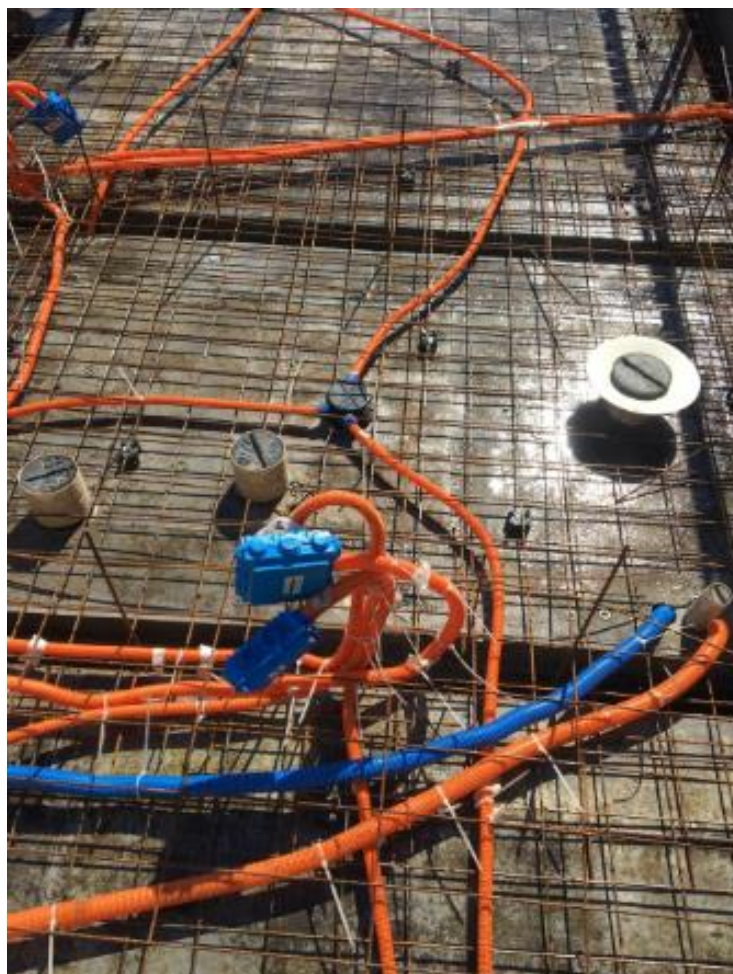
Figura 12: Instalações fixadas na armação de laje com abraçadeiras de nylon
