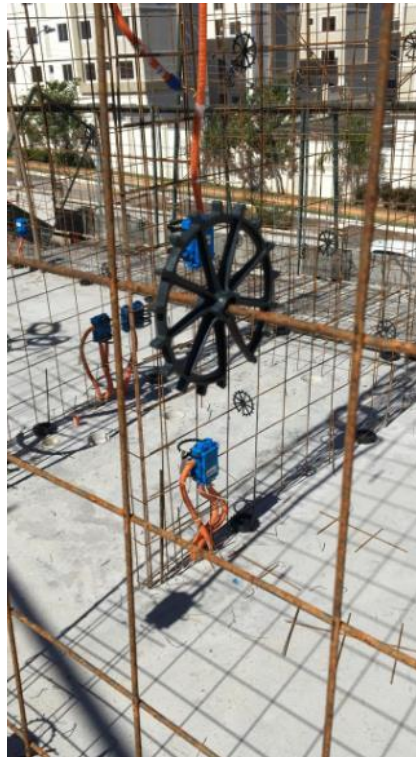
Figura 8: Espaçador posicionado na tela da parede
