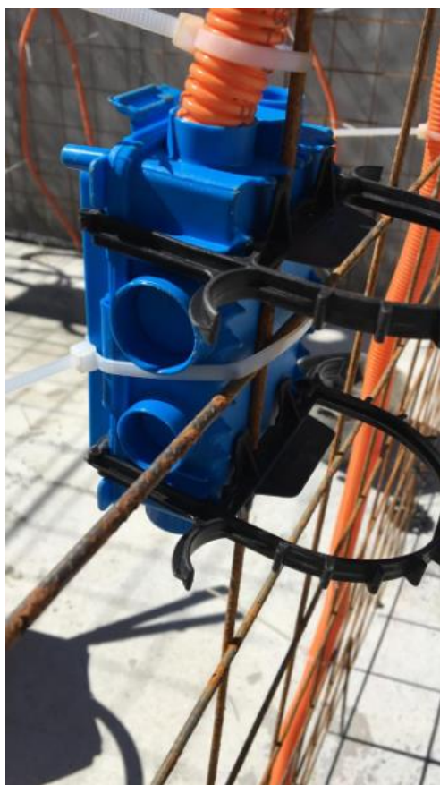
Figura 10: Caixa de passagem elétrica 4x2 com travamento na armação
