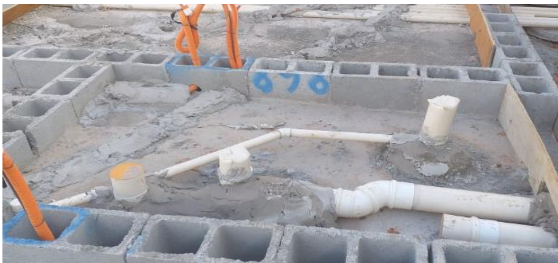
Figura 31: Kit Fundação Banheiro Térreo
