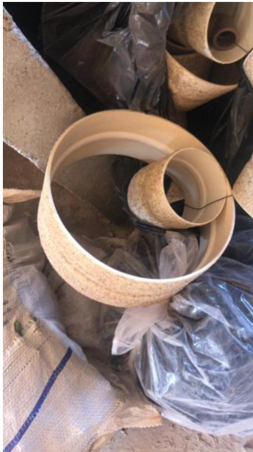
Figura 38: Passantes de laje envoltos com camada de areia.
