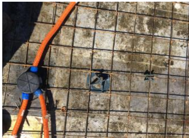
Figura 9: Espaçadores de armadura positiva e negativa na laje
