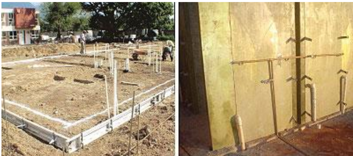
Figura 6: Instalações prediais em fundação do tipo Radier
