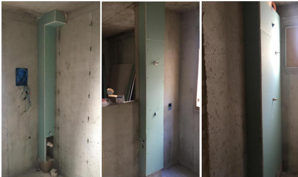
Figura 13: Shafts verticais em cozinha e banheiro
