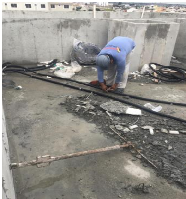
Figura 34: Instalação do Kit Estrutura 5º PVTO
