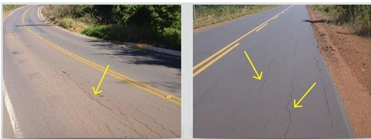
Figura 2.7 – Trincas Longitudinais
