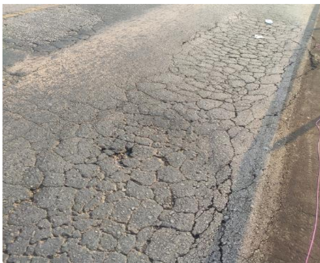
Figura 5.2 Trincas Interligadas
