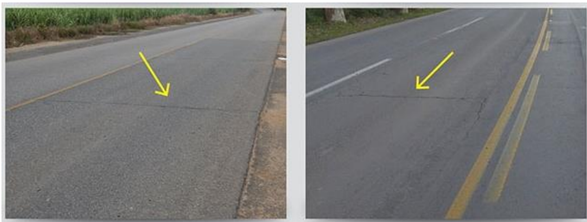
Figura 2.6 – Trincas Transversais
