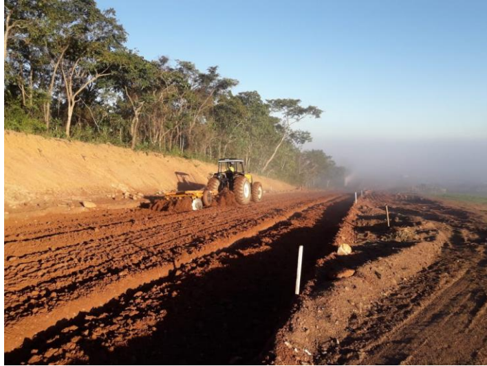
Figura 10 - Tratamento de material para execução das camadas estruturais do pavimento
