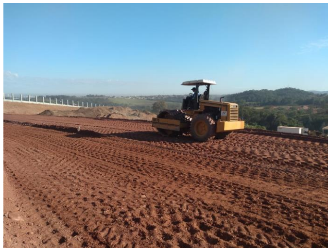
Figura 11 - Compactação de material
