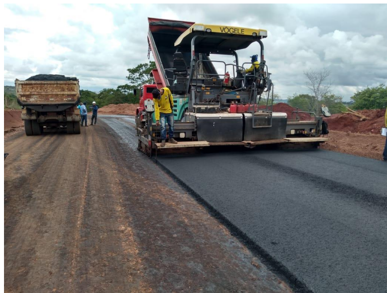
Figura 12 - Aplicação de massa asfáltica
