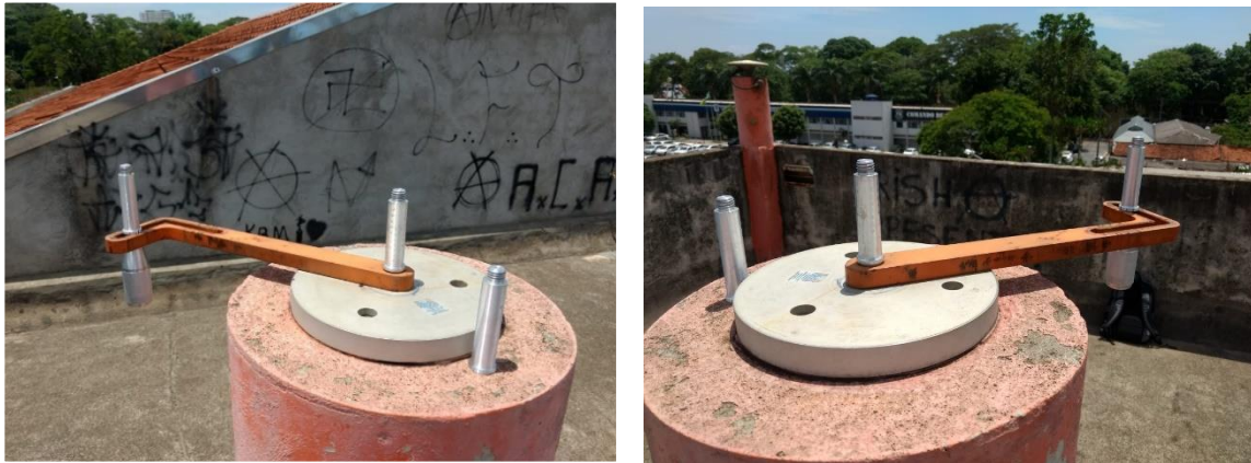
Figura 12 - Dispositivo de Simulação de Deslocamento Fixado na Base de Centragem Forçada.
