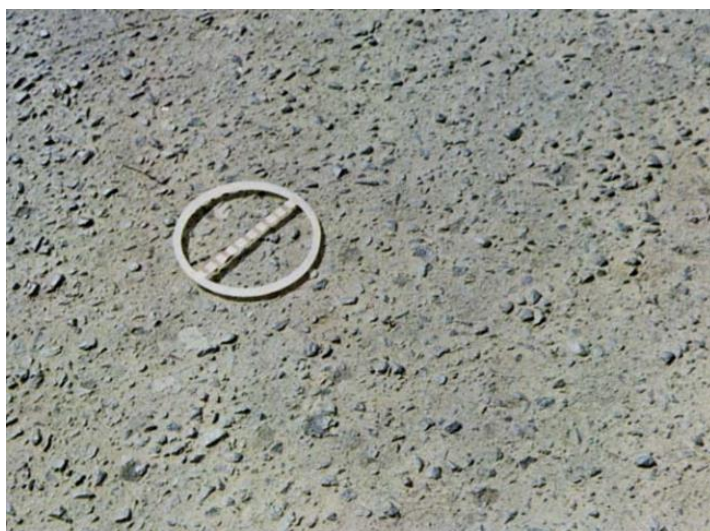
Figura 2.25: Desgaste
