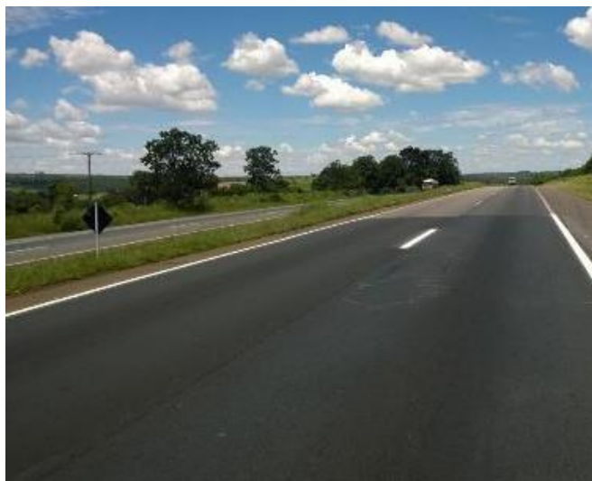
Figura 3.4: Serviço de microrrevestimento finalizado
