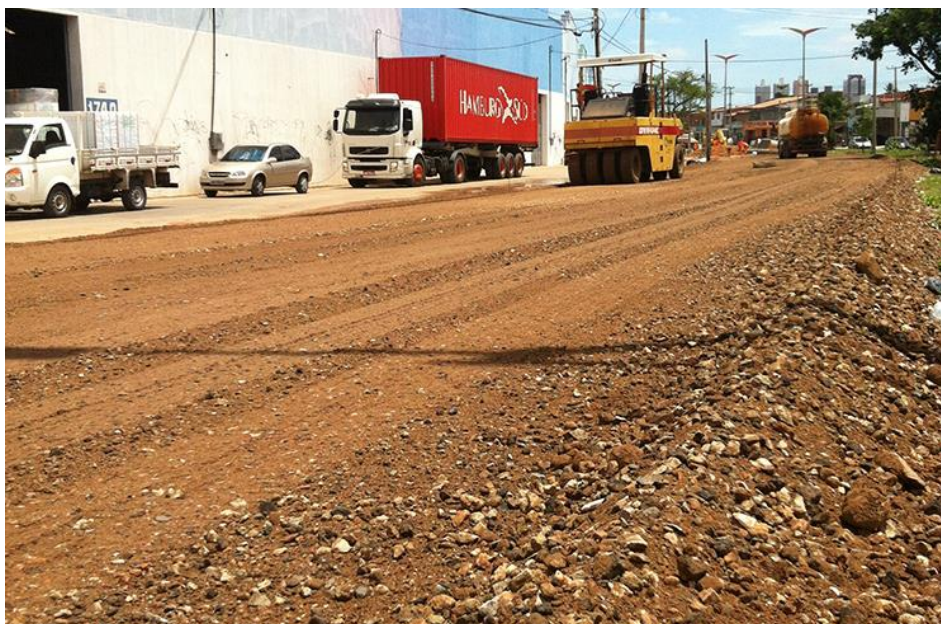
Figura 2.7: Base executada com material reciclado
