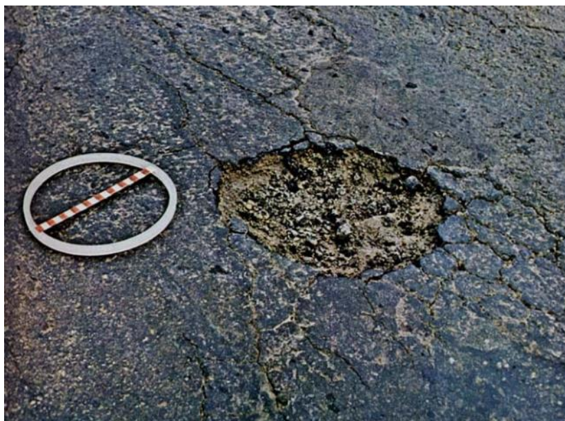
Figura 2.26: Panela ou Buraco
