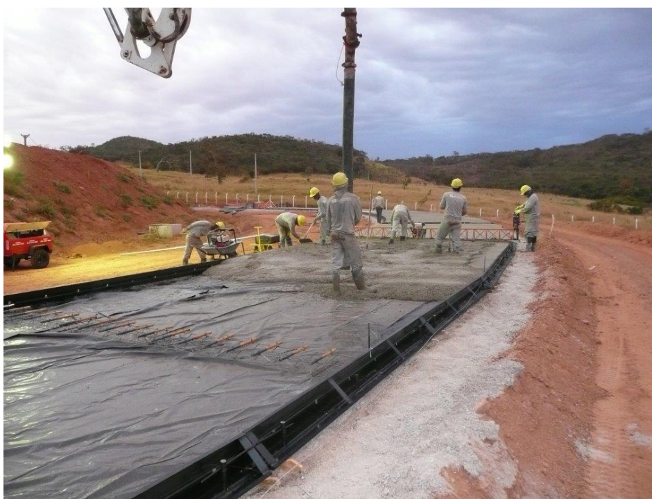
Figura 2.10: Execução de um revestimento de concreto armado
