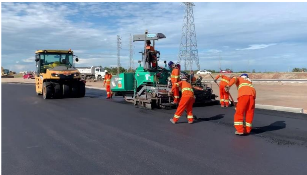
Figura 2.8: Execução de um revestimento flexível betuminoso
