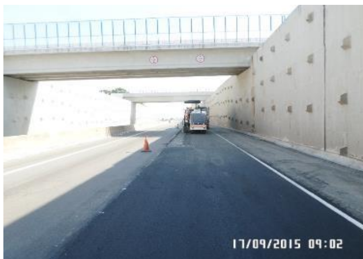
Figura 3.3: Recapeamento finalizado no serviço de fresagem
