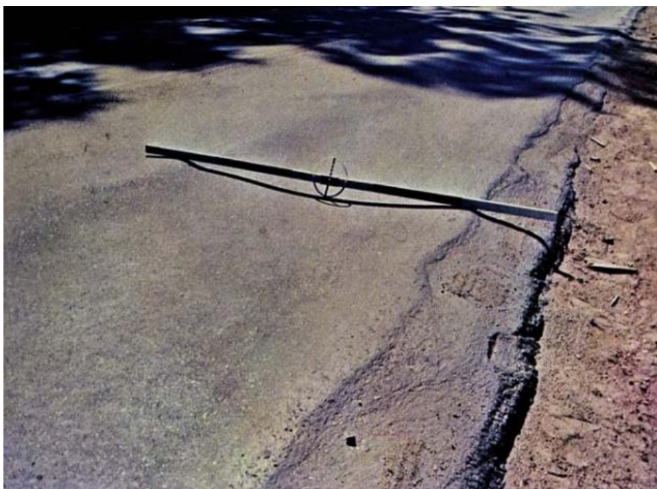
Figura 2.20: Afundamento plástico de trilha de roda
