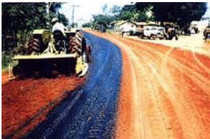
Figura 2.5: Base estabilizada com betume
