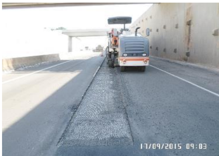
Figura 3.2: Retirada da capa asfáltica antiga no serviço de fresagem
