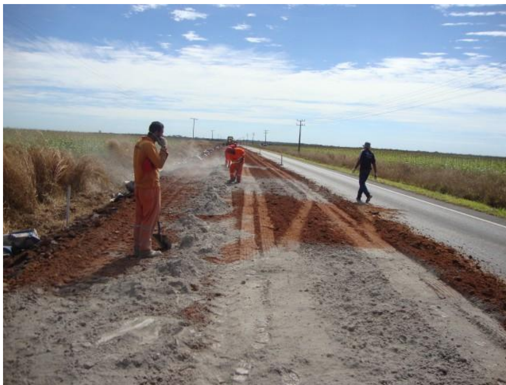
Figura 2.4: Base estabilizada com cimento
