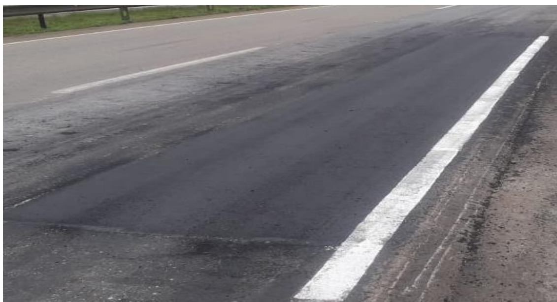
Figura 3.5: Serviço de tapa buraco finalizado
