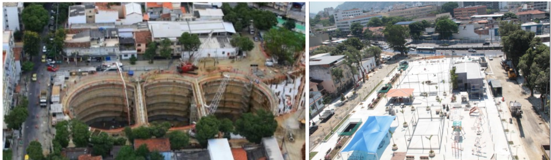
Figuras 9a e 9b: Reservatório da Praça Niterói (RJ).
