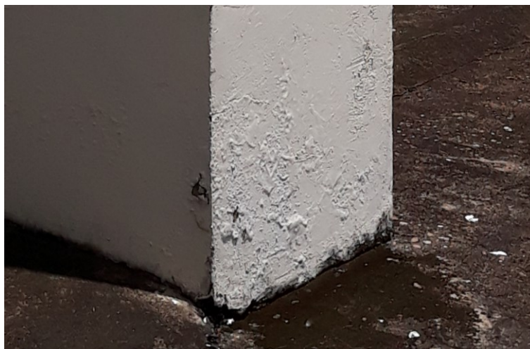
Figura 4.7 – Pintura com presença de bolhas
