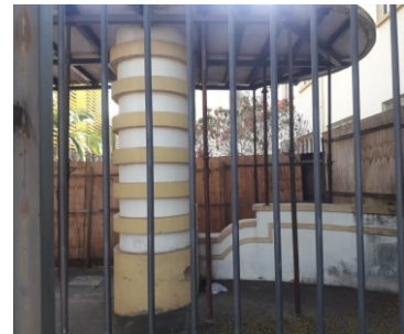
Figura 1.4 – Presença de escoras
