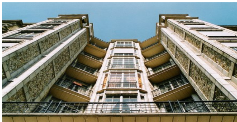
Figura 2.2 – Edifício da rua Franklin de Auguste Perret
