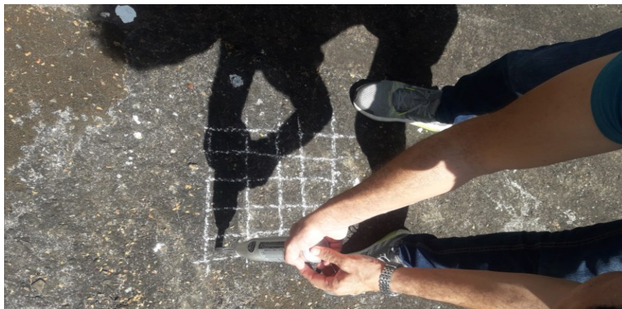
Figura 3.7 – Execução do ensaio de esclerometria
