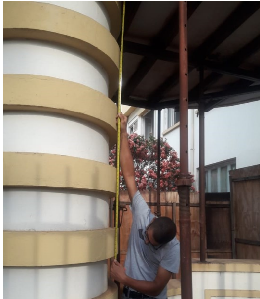
Figura 3.11 – Ensaio de verificação da flecha da laje
