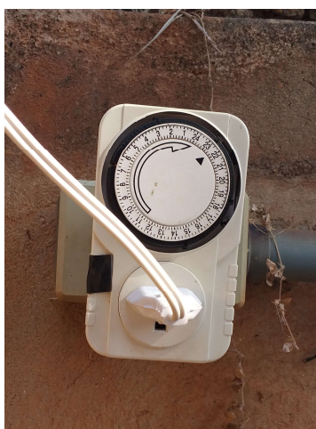
Figura 6: Temporizador instalado para controle do tempo de aplicação do efluente no leito de macrófitas
