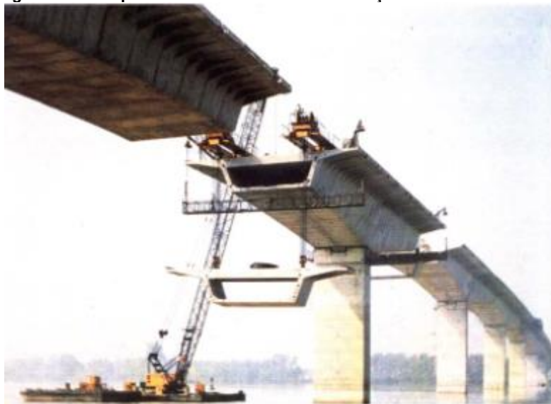
Figura 2: Ponte protendida executada em balanços sucessivos
