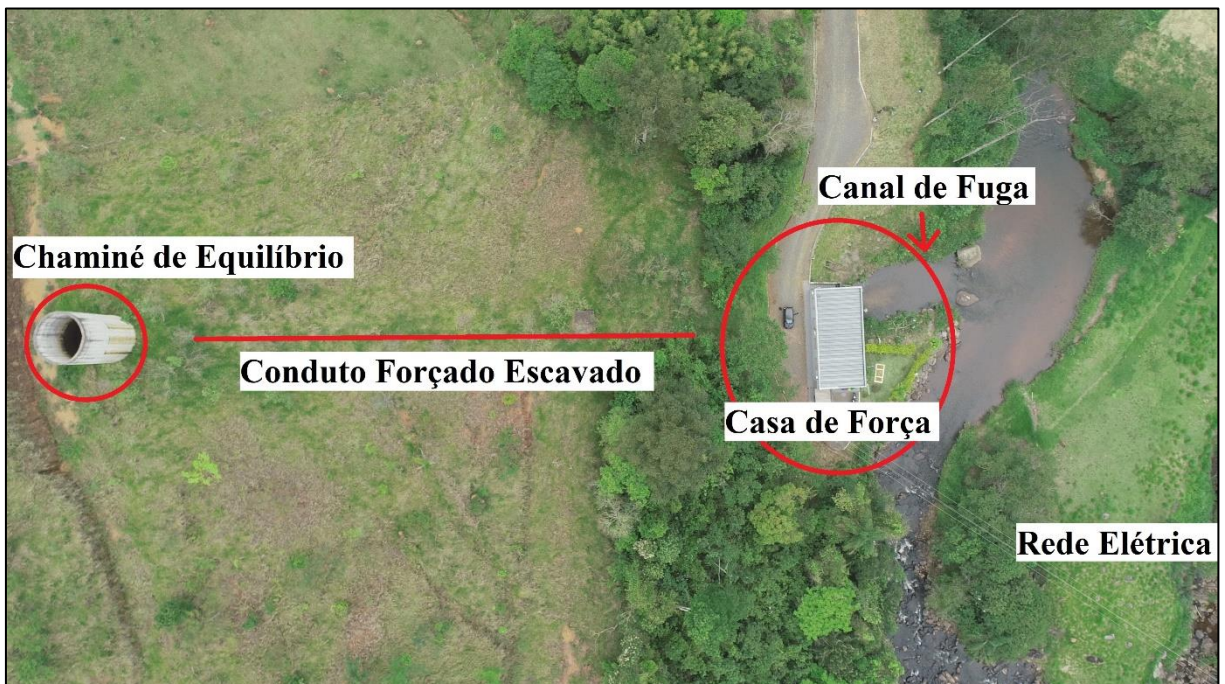
Figura 8 – Casa de força e outras estruturas da CGH MV, em Minas Gerais.
