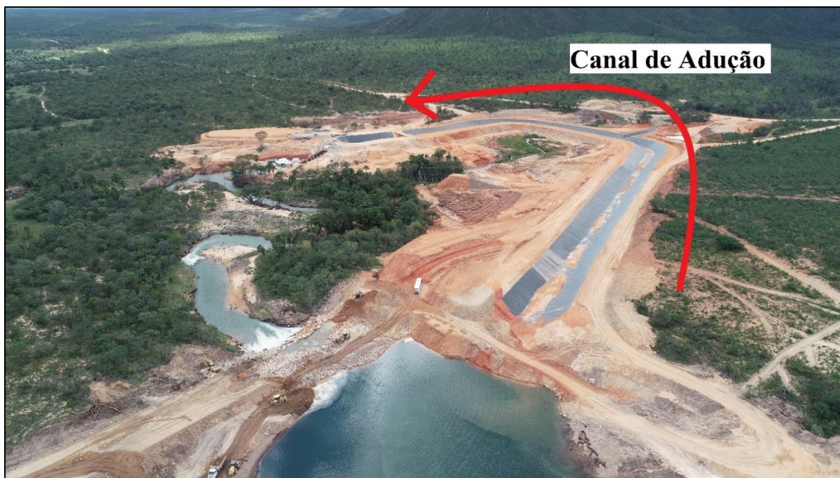
Figura 6 – Canal de adução em construção da CGH P, em Tocantins.
