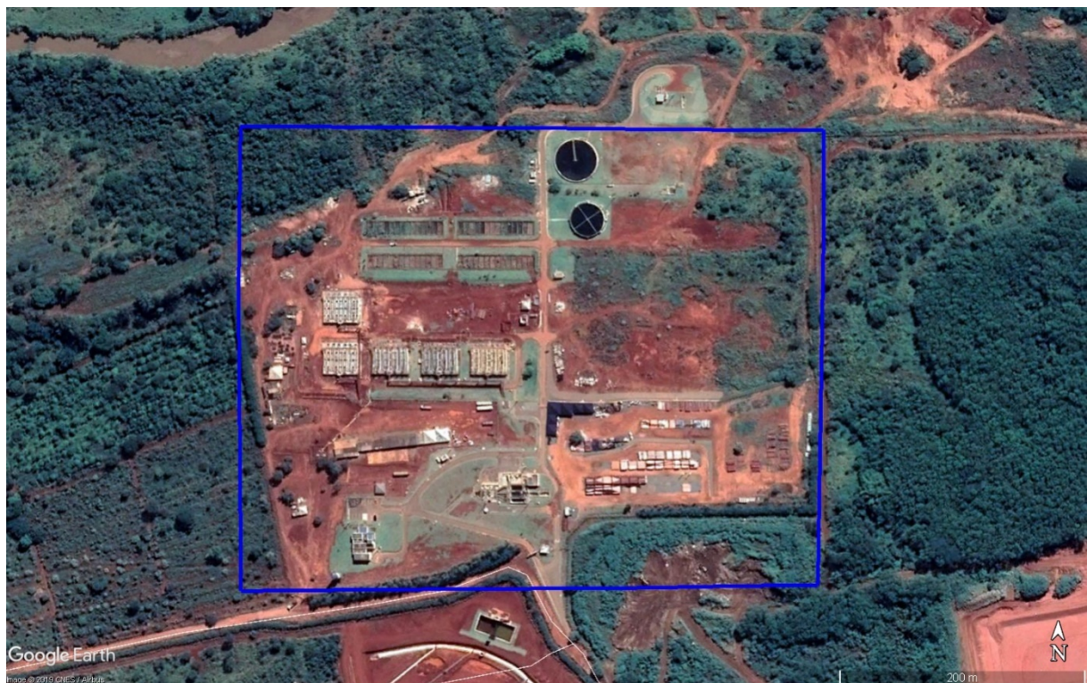
Figura 2 - Localização da ETE Santo Antônio
