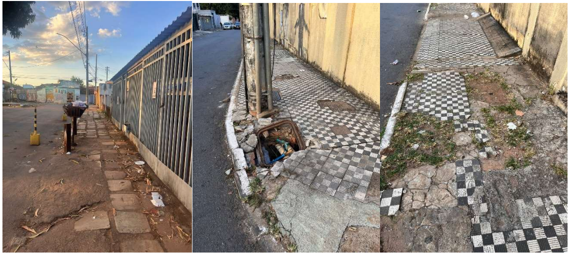
Figura 21 –Evidências do Bloco 2 – Condições do Pavimento na Rota da Avenida Paranaíba
