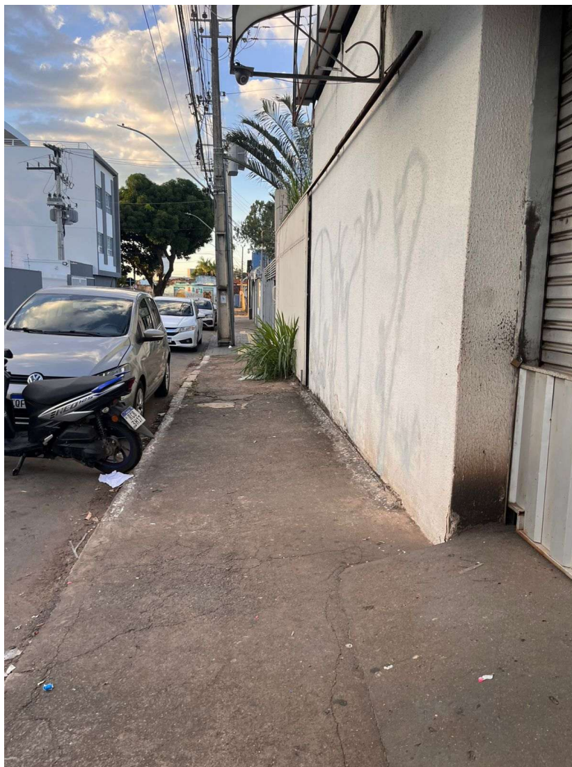
Figura 22 –Evidências do Bloco 3 -Inclinações na Rota da Avenida Paranaíba
