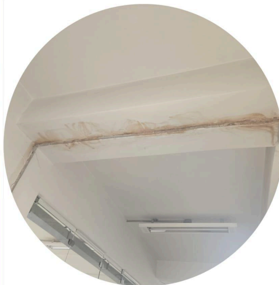
Figura 30 Corrosão Junta De Dilatação Localizada Entre Vigas
