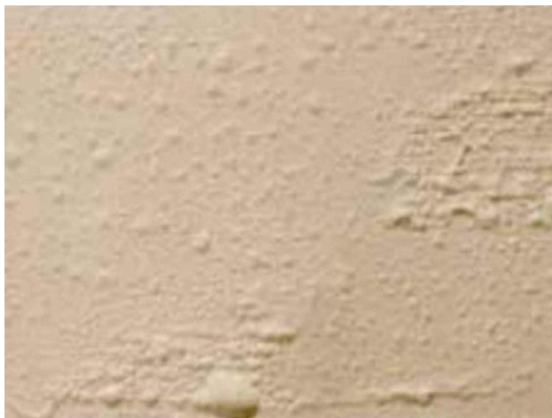
Figura 16 Bolhas Na Pintura
