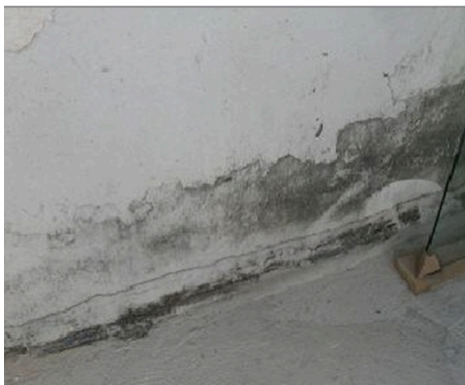
Figura 13 Manchas Decorrente De Capilaridade
