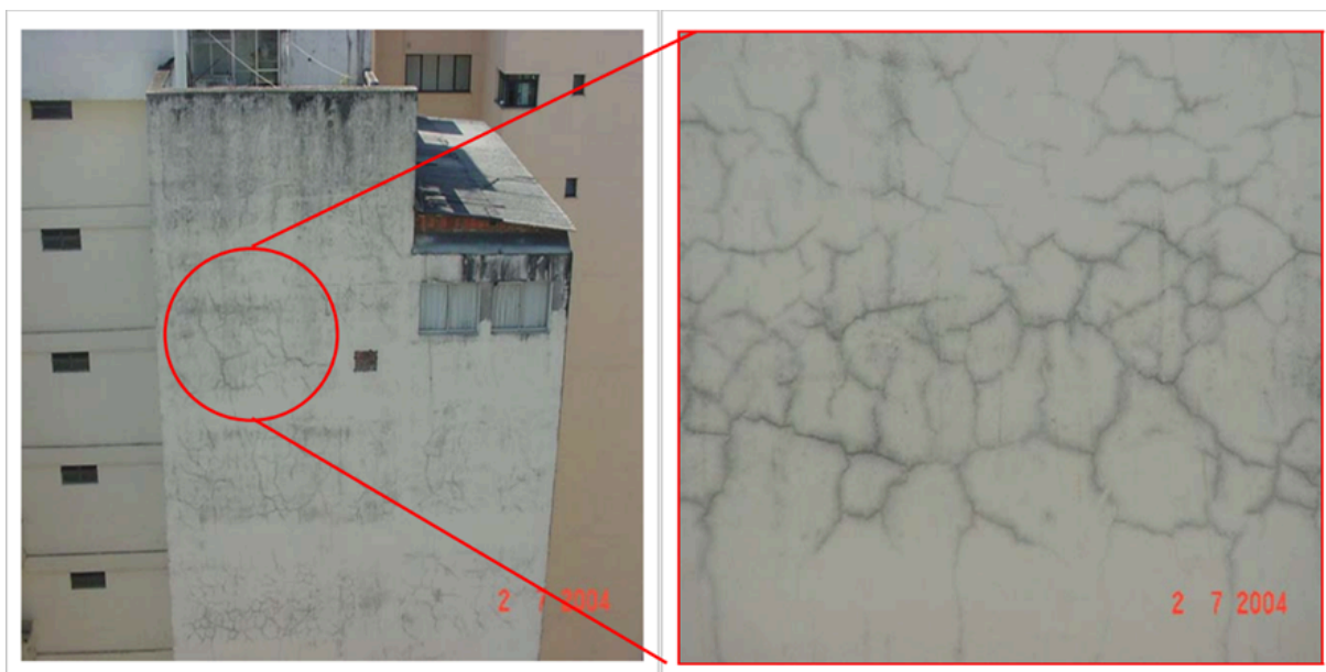
Figura 4 Fissuras Mapeadas
