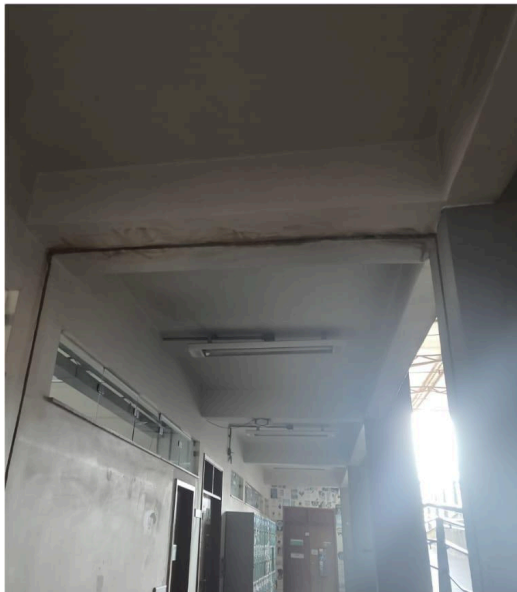
Figura 30 Corrosão Junta De Dilatação Localizada Entre Vigas
