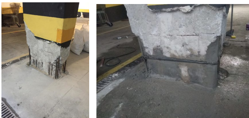
Figura 06 - Recuperação Estrutural de Pilares
