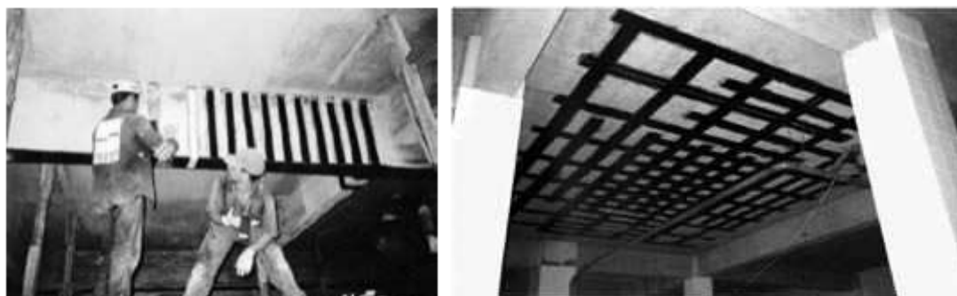
Figura 09 - Reforço de vigas (flexão e cisalhamento) e lajes (flexão) com lâmina de fibras de carbono
