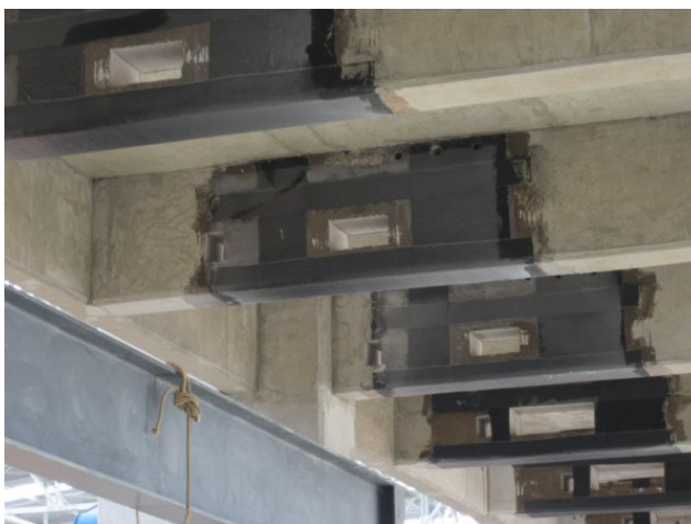
Figura 10 - Reforço em aberturas de viga para passagem de tubulações.
