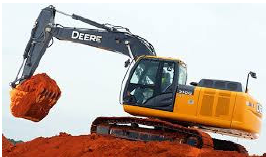
Figura 2 – Escavação de material de 1º categoria
