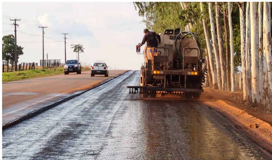
Figura 18 - Execução de Imprimação Asfáltica
