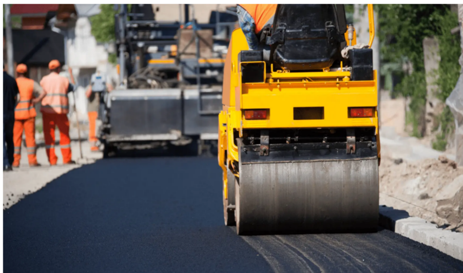
Figura 16 - Execução de revestimento em concreto asfáltico
