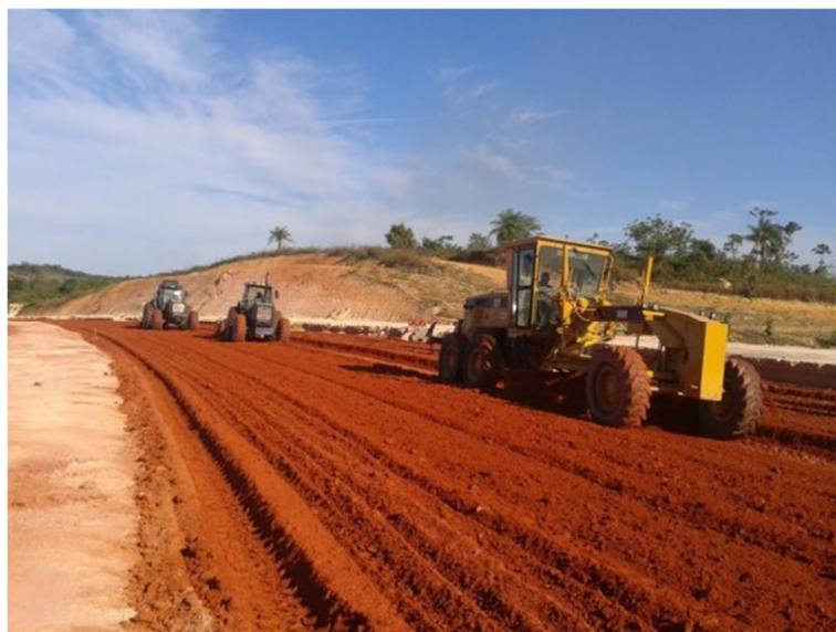
Figura 1 – Execução de Terraplenagem
