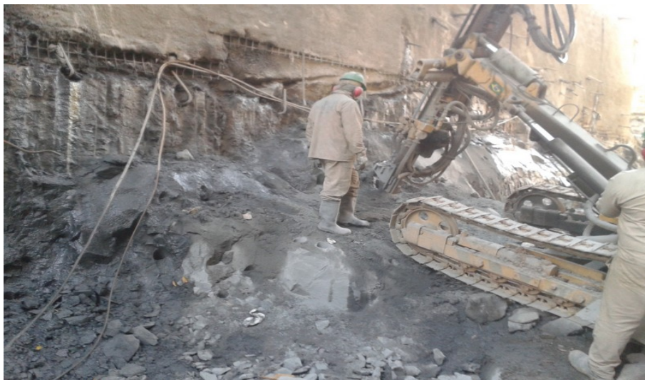
Figura 4 – Explosão de material de 3º categoria
