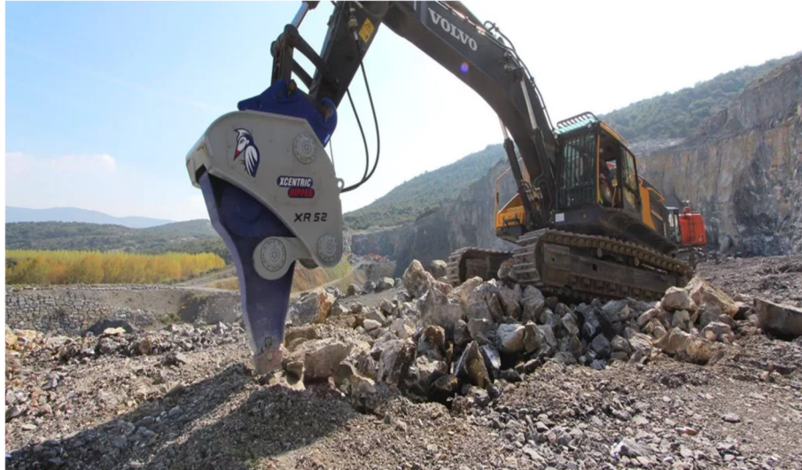
Figura 3 – Escarificação de material de 2º categoria
