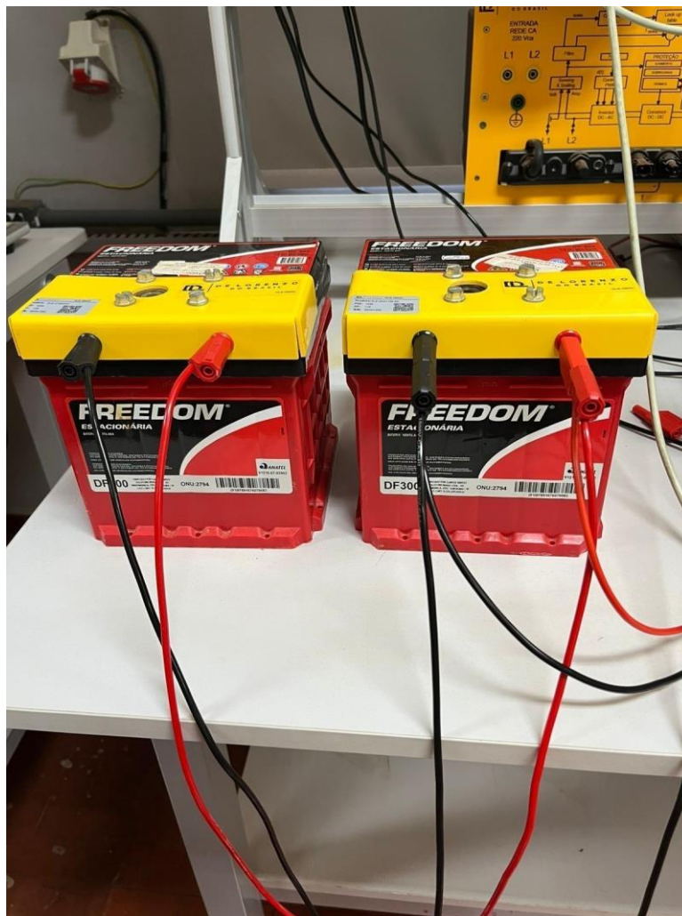
Figura 3: Baterias Freedom DF300 conectadas em paralelo
