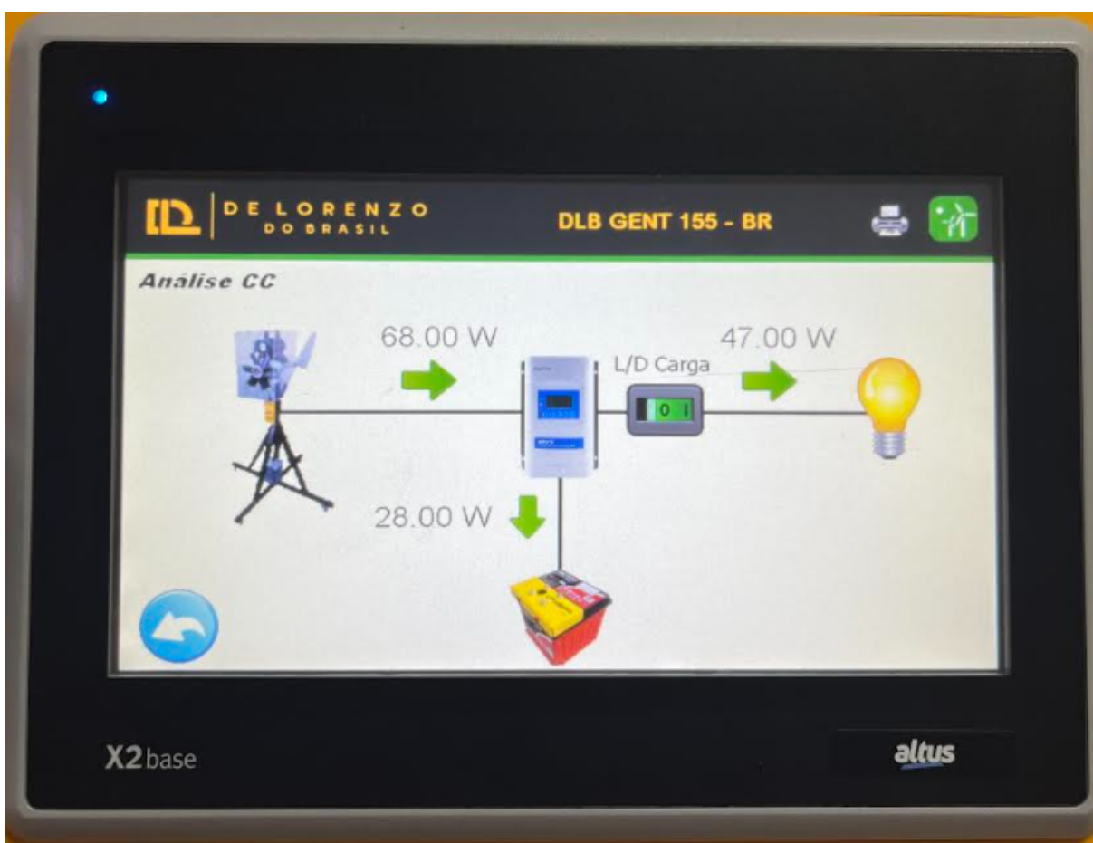
Figura 22 – Tela da IHM com ilustração do fluxo de energia do sistema para o Cenário 2, operando com o aerogerador em 100% da velocidade.
