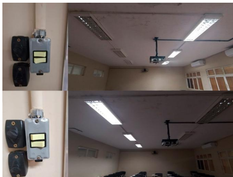
Figura 15 - Divisão dos Circuitos das Luminárias
